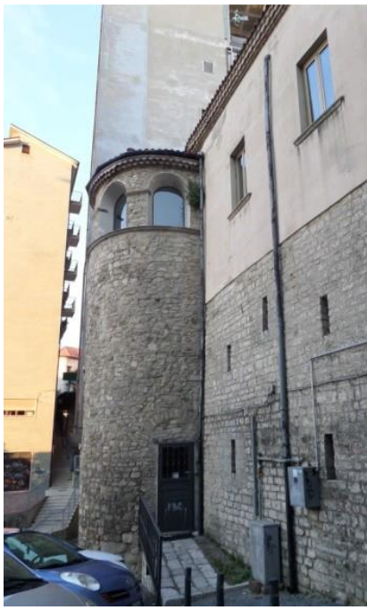
Figura 55: Torre fachada norte Fuente: Potentia medievale
