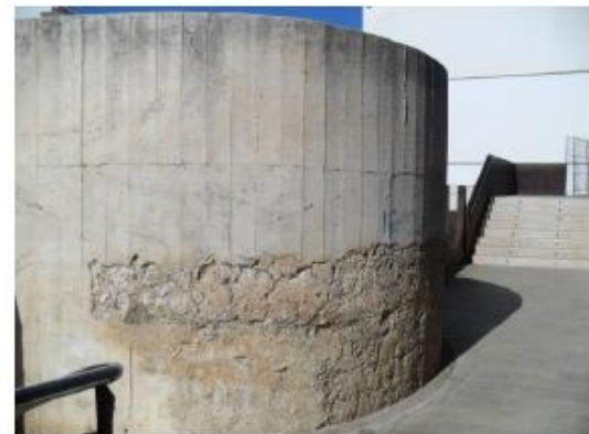
Figura 38: Detalle de la torre. Fuente: Elaboración propia.
