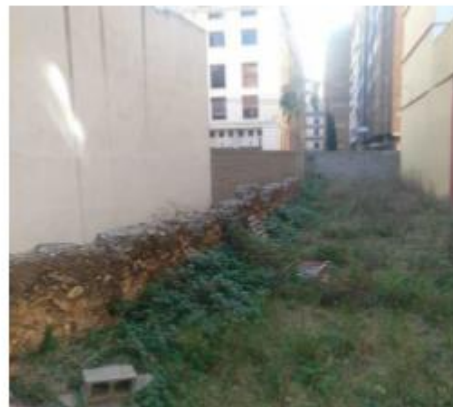
Figura 18: Detalle del muro existente. Fuente: Noelia Mateo Mansanet.
