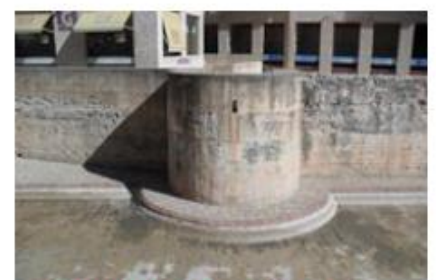
Figura 21: Detalle de la torre 19. Fuente: Elaboración propia.
