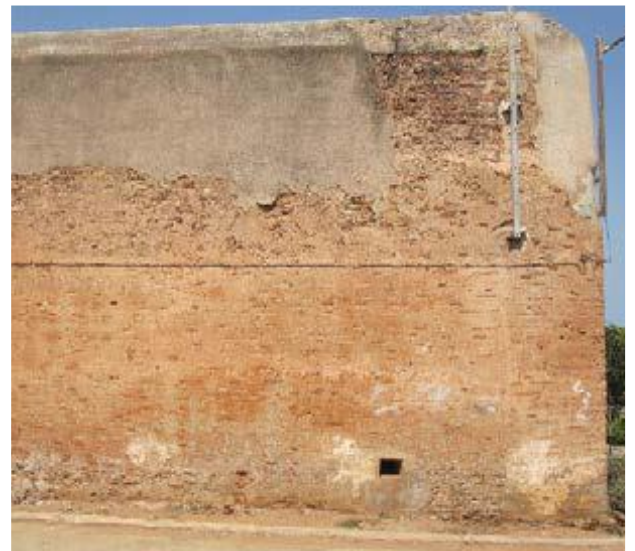
Figura 52: Esquina Suroeste de la muralla donde se puede ver el añadido efectuado en los años 70 sin respetar la tapia original. Fuente: Enrique Íñiguez Rodríguez
