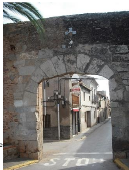
Figura 47: Puerta de Poniente (Valencia). Estado actual.
