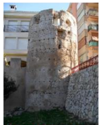
Figura 12: Detalle de la torre 23. Fuente: Elaboración propia.
