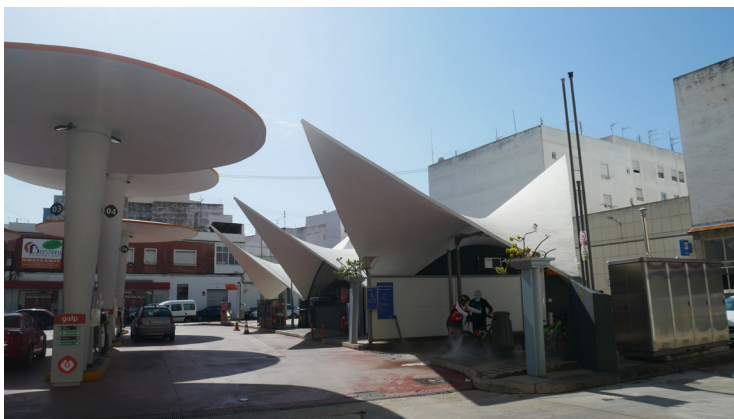
Fig. 113. Fotografia estat original del conjunt de l'estació de servici.
