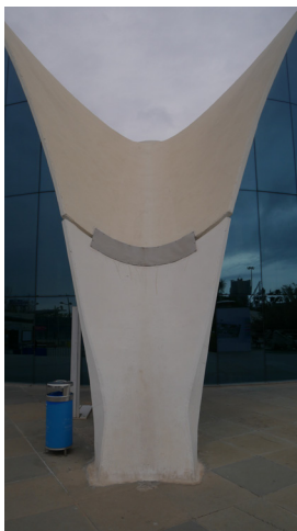
Fig. 38. Detalls de l'articulació que relaciona superfície i suport. Escala de l'espessor de la superfície.
