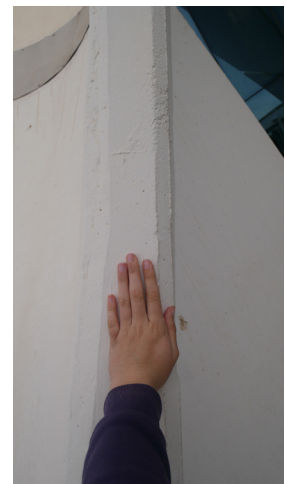
Fig. 38. Detalls de l'articulació que relaciona superfície i suport. Escala de l'espessor de la superfície.
