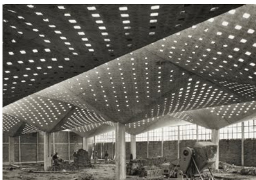
Fig. 110. Indústria tèxtil High Life (1955), en Coyoacán. Combina de forma senzilla els paraigües de hypars amb l'entrada de llum natural. Fèlix Candela.
