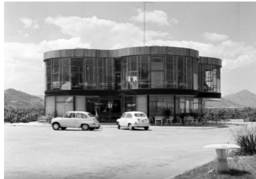
Fig. 108. Edifici Ariston. Arquitecte Marcel Beuer. Cafeteria El Rebollet.
