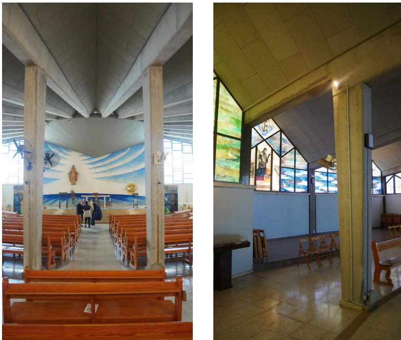
Fig. 147. Detall de la coberta i la continuació de les bigues.
