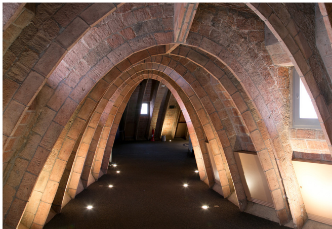
Fig. 40. Passadís del bloc La Pedrera a Barcelona. Catenàries invertides construïdes amb rajoles massisses.
