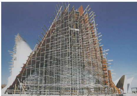
Fig. 39. Detalls del procés de construcció. Encofrat de fusta i cimbres metàl·liques. Projecció de formigó a la superfície.
