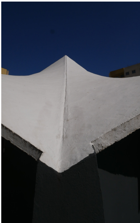
Fig. 117. Unió de dos paraboloides hiperbòlics a través d'una recta, i el suport.
