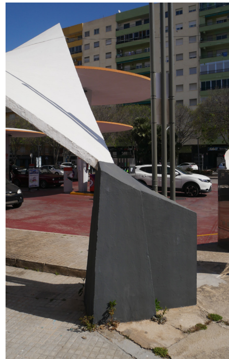
Fig. 118. Vista de l'encontre entre la superfície i el suport.
