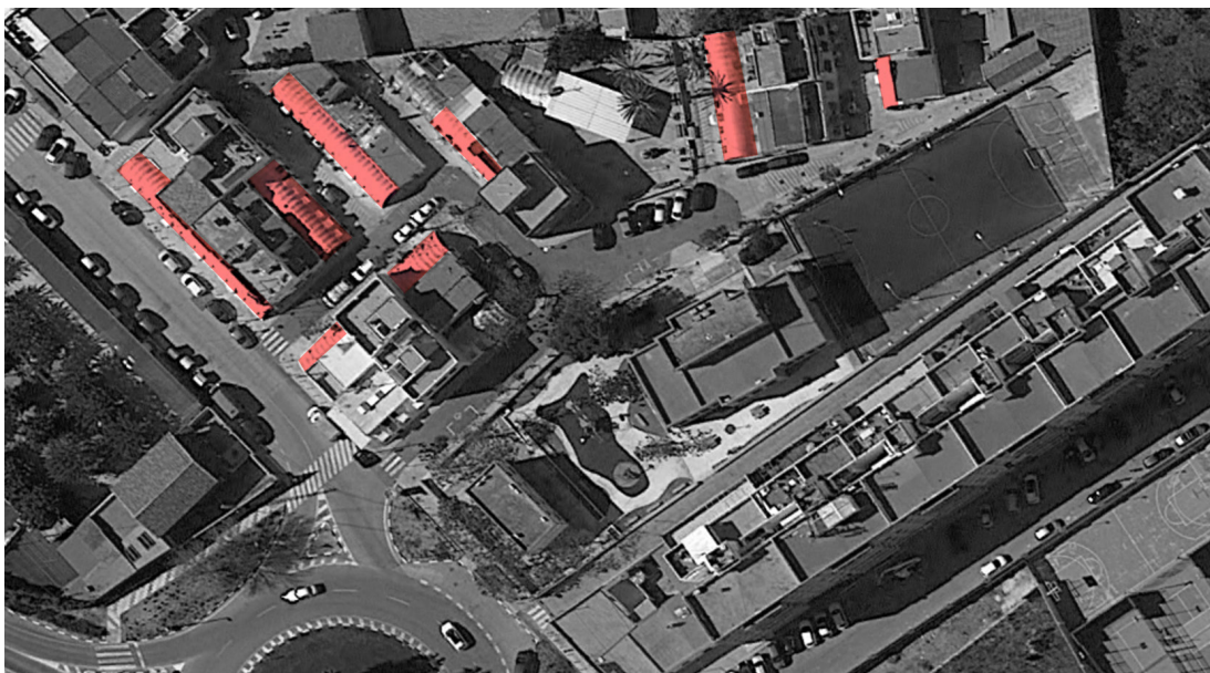
Fig. 53. Fotografia aèria del Grup Residencial Marqués de Valterra. El Perellonet. En roig el cas d'estudi. Google Earth. 39°18'29.3"N 0°17'51.3"W (orientada al Nord)
