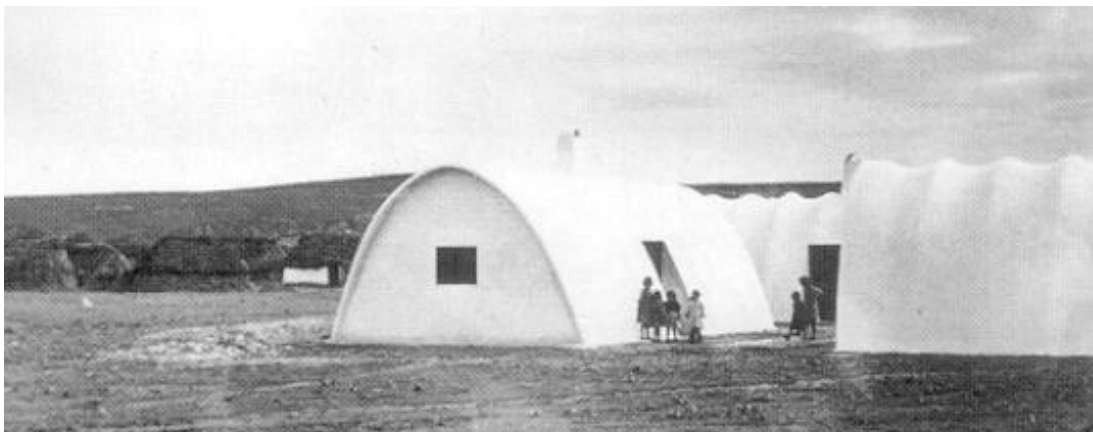
Fig. 48. Grup residencial amb el Sistema Ctesiphonte, en Palma del Río, Còrdova.
