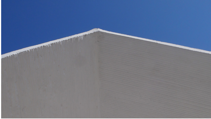
Fig. 114. Unió de dues unitats de paraboloides hiperbòlics.
