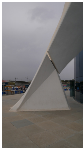
Fig. 38. Detalls de l'articulació que relaciona superfície i suport. Escala de l'espessor de la superfície.
