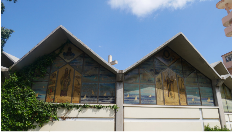
Fig. 145. Vista de l'extrem exterior de la coberta.
