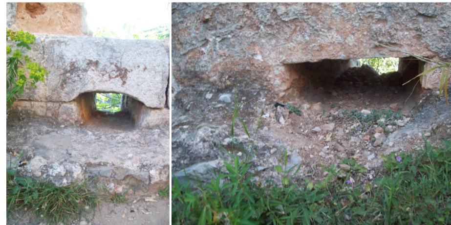
Fig.148. Desagüe trapezoidal-ovalado
