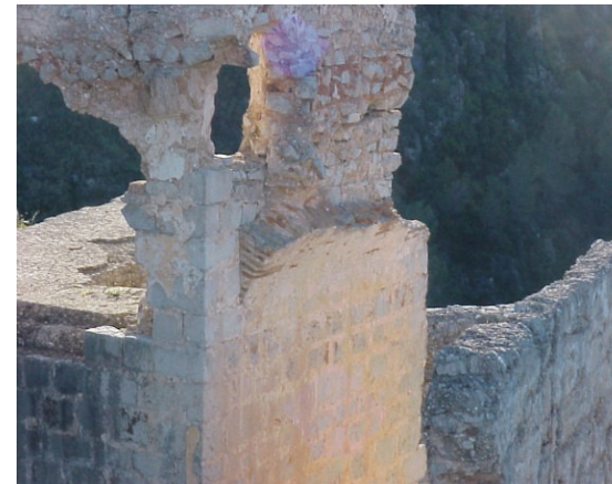
Fig.142. Edificación sobre Capilla y Corredor 1
