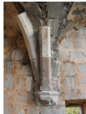
Fig. 126. Arranque arco
