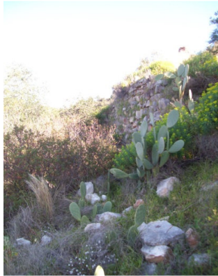
Fig.102. Muralla zona oeste
