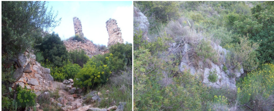
Fig.112. Acceso recinto superior
