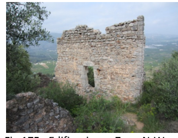
Fig.175. Edificaciones Zona N-W
