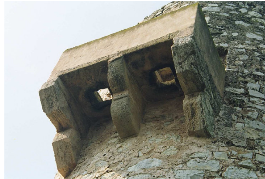
Fig.61. Vista de la torre vigía.
