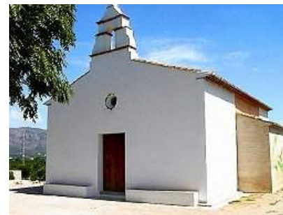
Fig. 41 Vista dirección oeste-este desde puerta cristiana.
