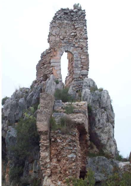
Fig. 157: Vista frontal torre homenaje
