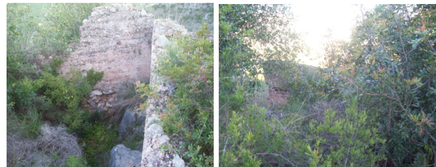
Fig.120. Muralla Zona Oeste
