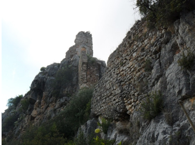
Fig. 121. Muralla Zona Sur
