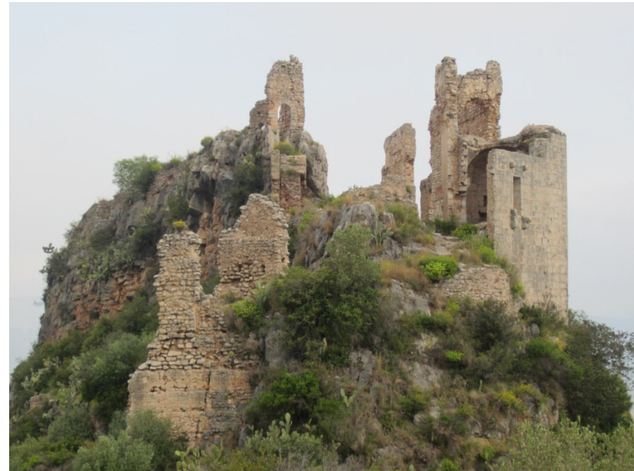
Fig.97. Vista general del segundo recinto del Castillo Alfàndech
