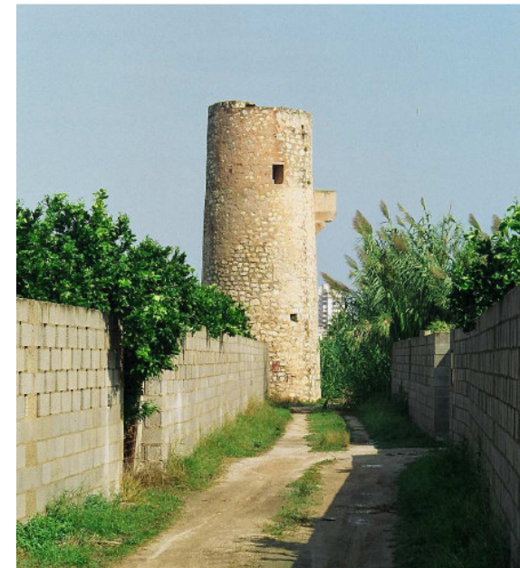
Fig.60. Vista de la torre vigía.
