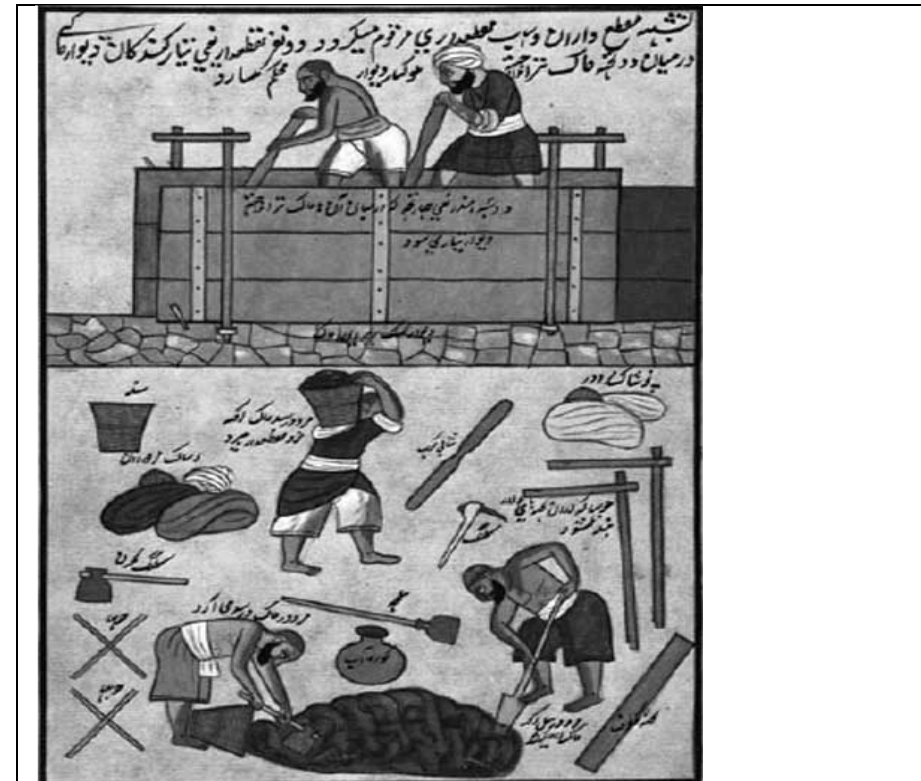
Fig.178. Ejecución de la tapia. Relación de oficios hecha en Cachemira en 1850.
