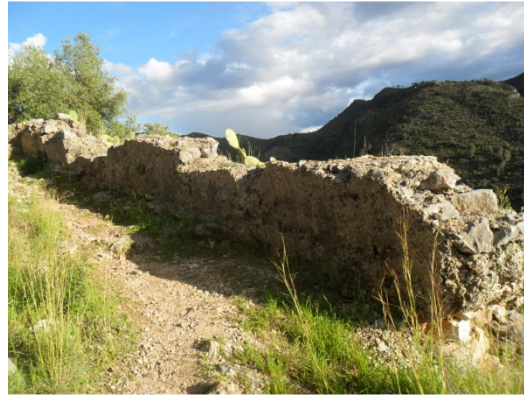
Fig.103. Muralla zona sur.
