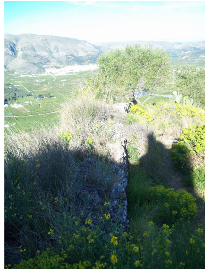
Fig. 122. Muralla Zona Sur
