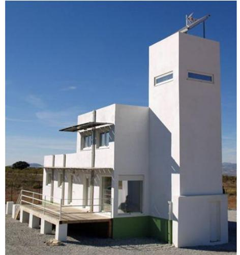
Existen variantes: **Torre de viento de dirección constante** con una abertura en la dirección predominante del viento; **Torre de paredes cruzadas** con más aberturas y canalizaciones paralelas separadas, tantas como vientos predominen en la zona; **Torre evaporativa** incorpora un sistema de evaporación que humidifica el aire entrante, fuente, pequeño estanque. Con una **Caperuza rotatoria** se consigue recoger el viento más fuerte en cada momento.
