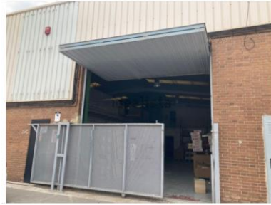
Figura 20. Fachada de la nave
