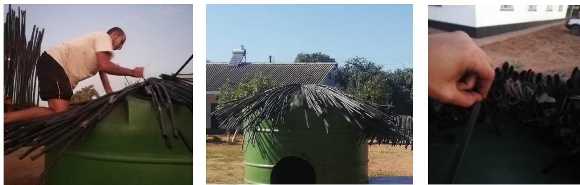
Ilustración 97: Instalación del techo de las casitas. Fuente: Propia
