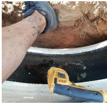
Ilustración 61. Taladrado filtrado agua. Fuente: Propia
