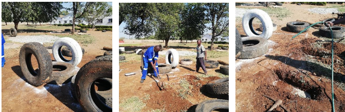
Ilustración 73: Preparación y cavado de las zanjas. Fuente: Propia
