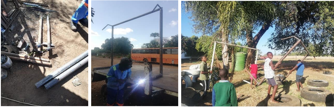
Ilustración 166: Elaboración de las estructuras. Fuente: Propia
