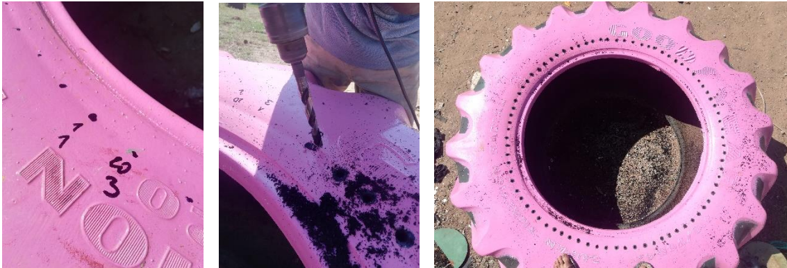
Ilustración 161: Taladrado de la corona del neumático. Fuente: Propia
