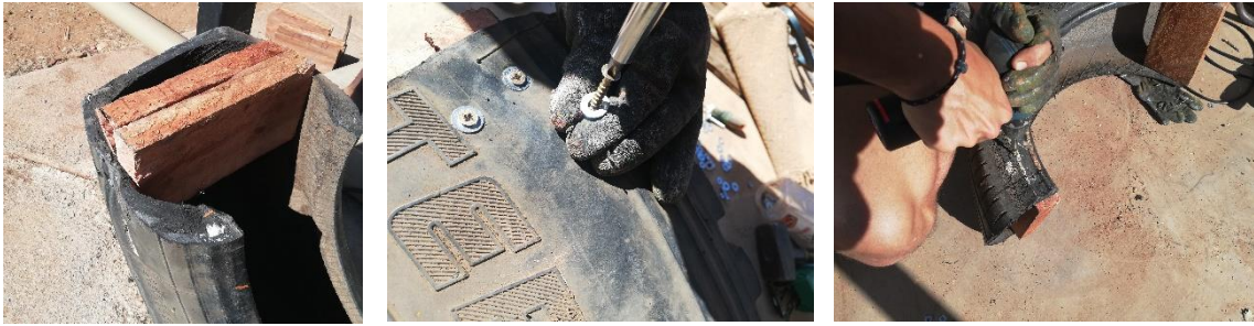
Ilustración 174: Unión de los lisones y los neumáticos. Fuente: Propia
