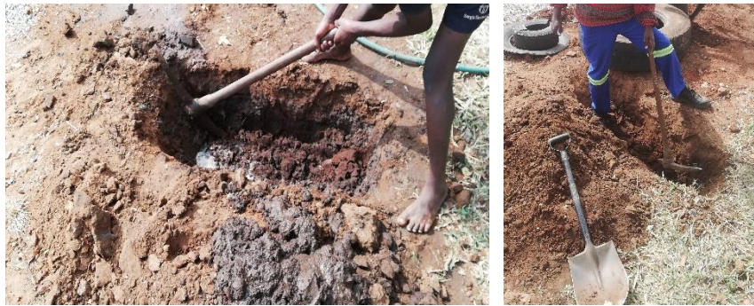
Ilustración 126: Elaboración de la zanja. Fuente: Propia
