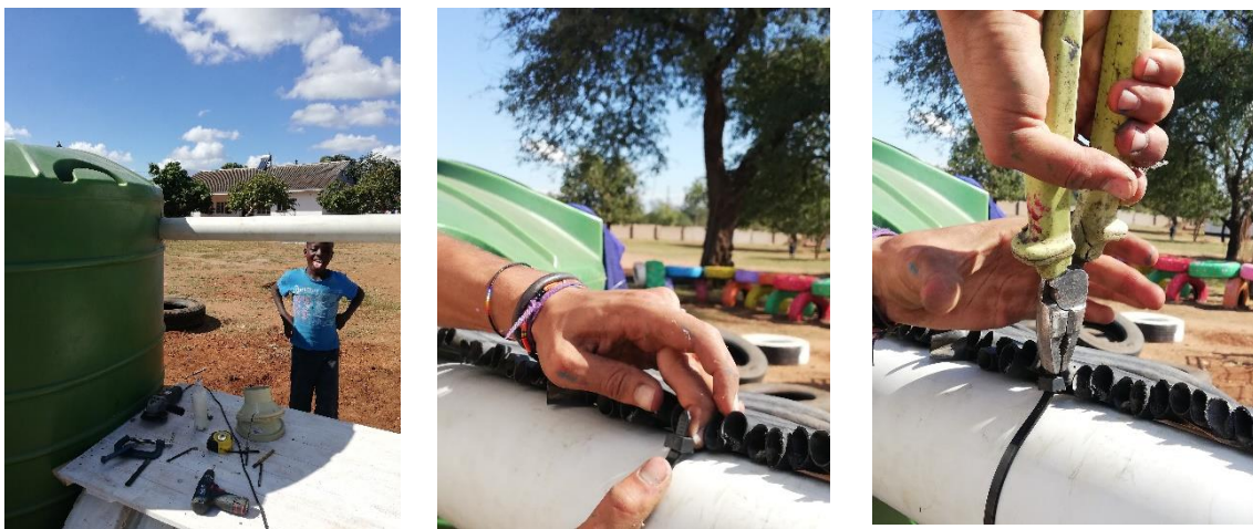
Ilustración 95: Instalación del techo del mercado. Fuente: Propia
