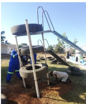
Ilustración 157: Instalación y cimentación de la estructura. Fuente: Propia
