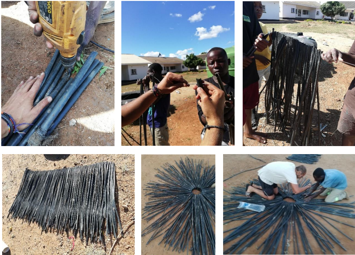
Ilustración 94: Realización del techo del mercado y las casitas. Fuente: Propia
