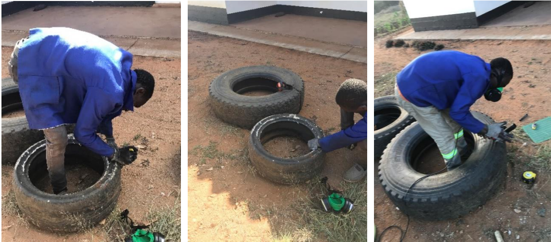
Ilustración 171: Corte de neumáticos por la mitad. Fuente: Propia
