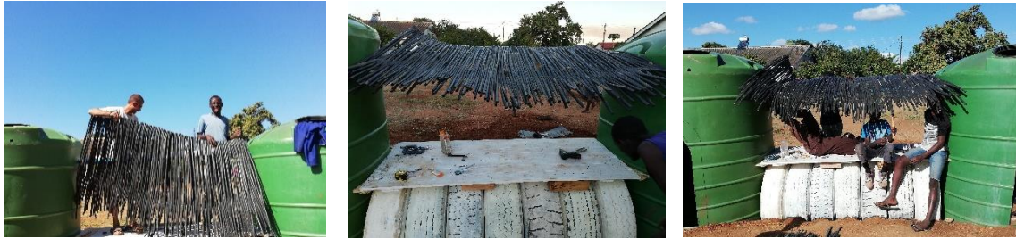
Ilustración 96 Instalación del techo del mercado parte 2. Fuente: Propia
