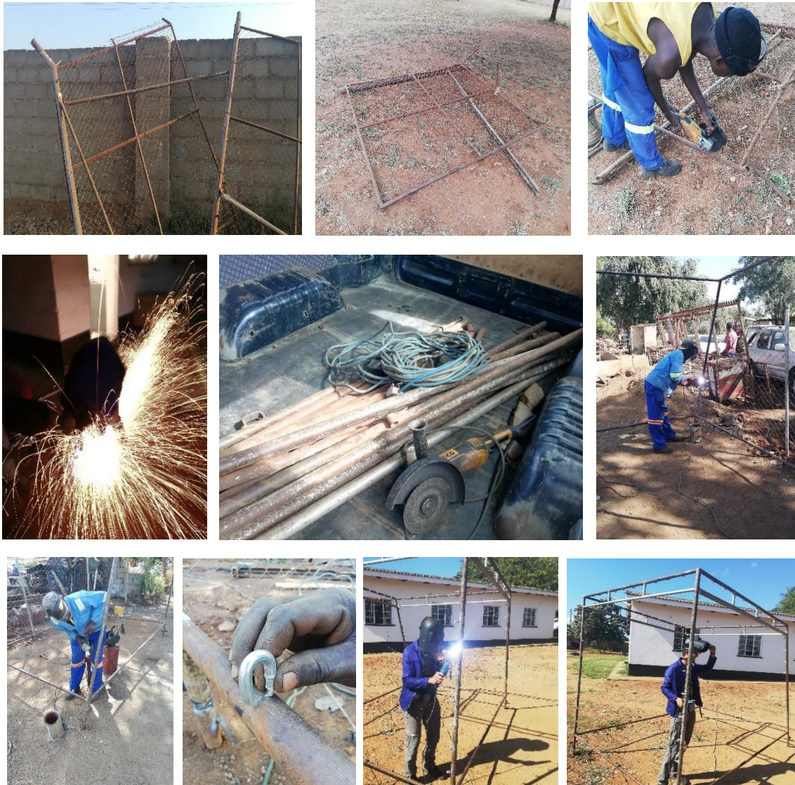
Ilustración 136: Elaboración de la estructura de la red de trepa. Fuente: Propia
