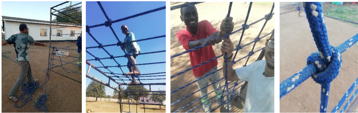
Ilustración 137: Anudado y trenzado de la red. Fuente: Propia
