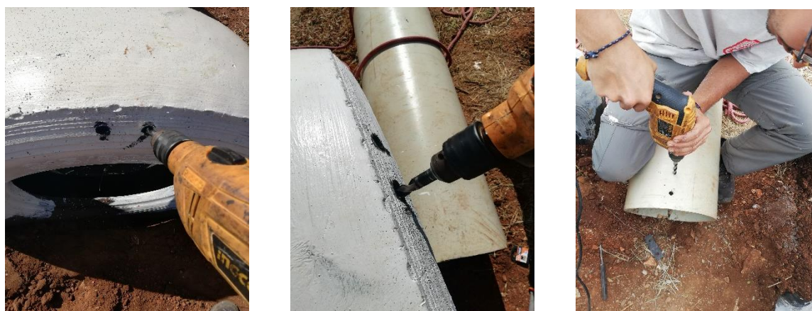
Ilustración 149: Taladrado de los neumáticos. Fuente: Propia
