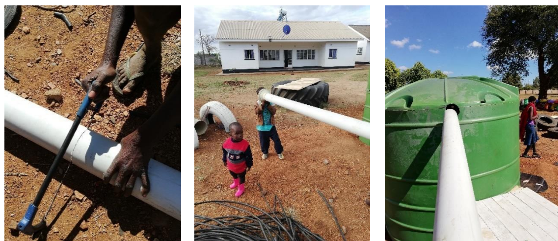
Ilustración 98: Corte de tubos para el speaking phone. Fuente: Propia
