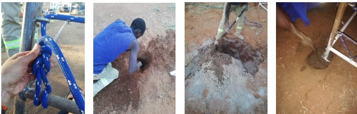
Ilustración 139: Cimentación de la estructura de la red de trepa. Fuente: Propia
