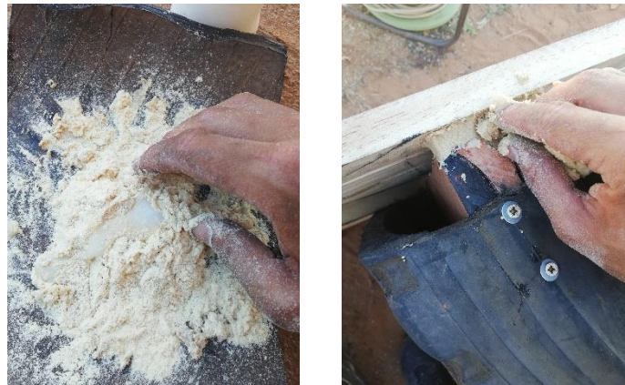
Ilustración 175: Relleno de huecos de las uniones. Fuente: Propia
