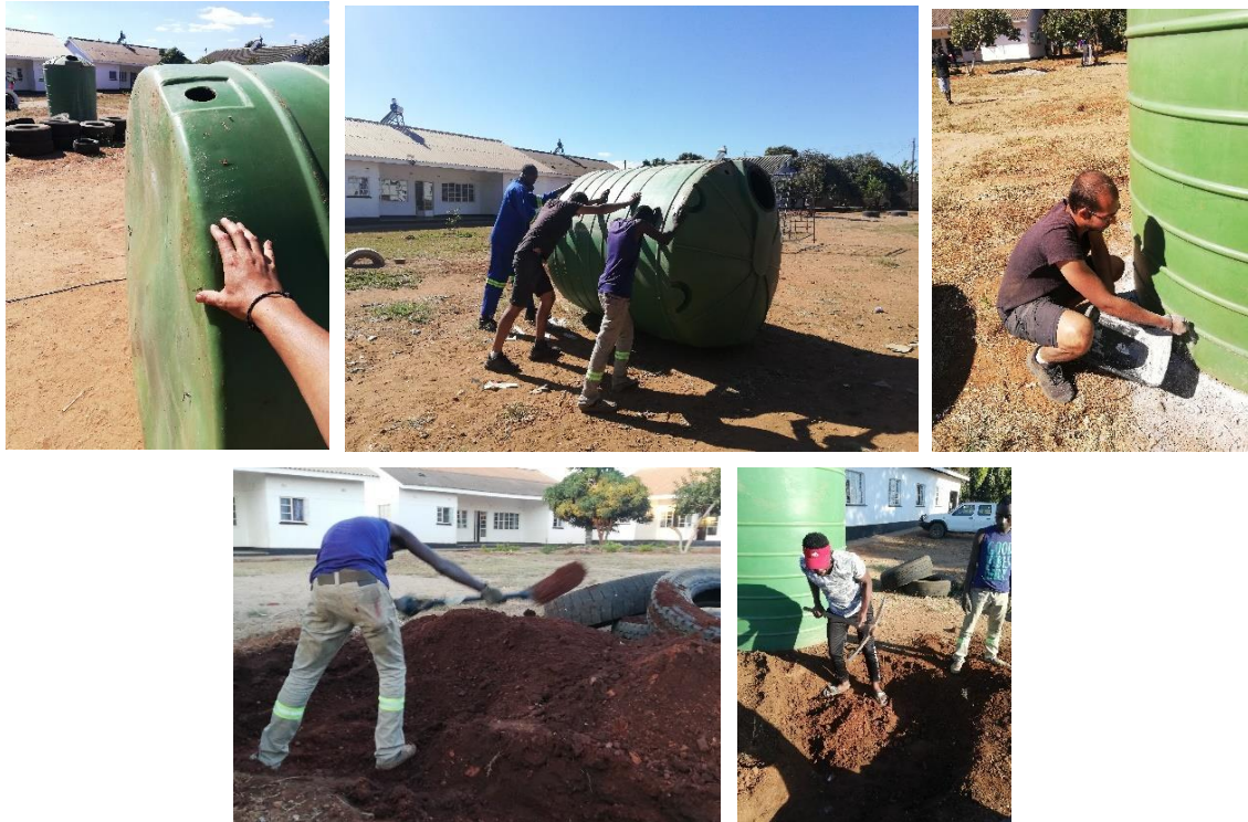
Ilustración 87: Cavado e instalación de los tanques de agua. Fuente: Propia
