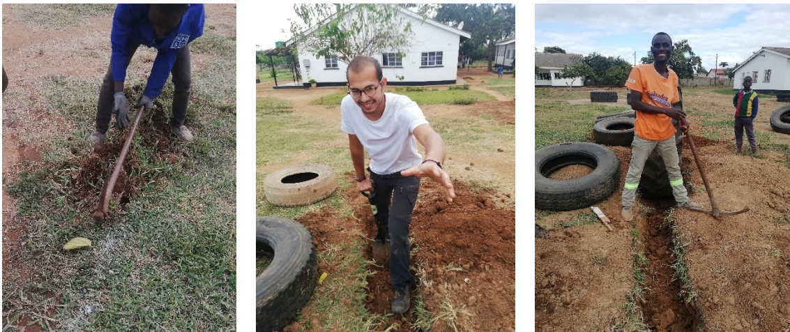
Ilustración 143: Elaboración de la zanja para el puente. Fuente: Propia
