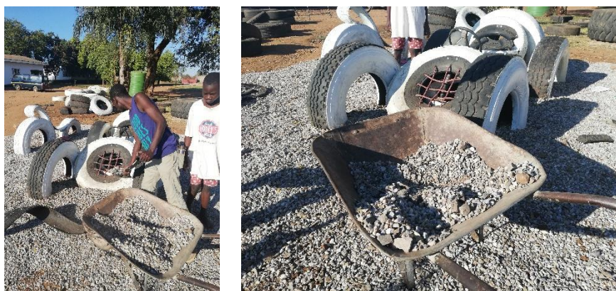
Ilustración 78: Instalación de grava. Fuente: Propia
