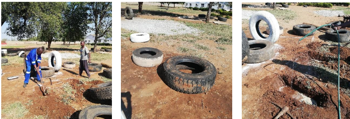
Ilustración 81: Preparación y cavado de las zanjas. Fuente: Propia
