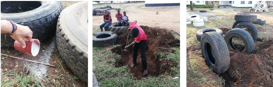
Ilustración 68: Preparación y cavado de la zanja. Fuente: Propia
