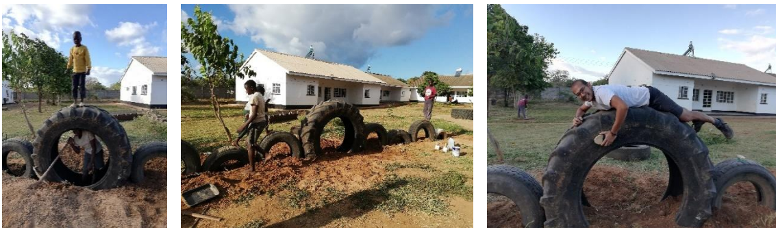
Ilustración 144: Colocación de los neumáticos y cepillados. Fuente: Propia
