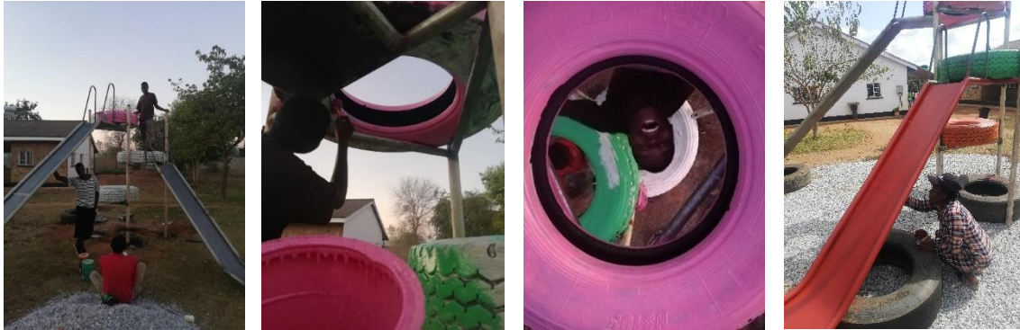
Ilustración 158: Pintura de la estructura. Fuente: Propia
