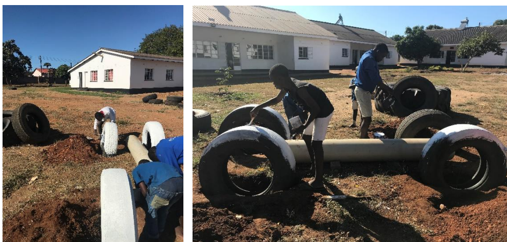
Ilustración 148: Elaboración de la zanja colocación de ruedas. Fuente: Propia
