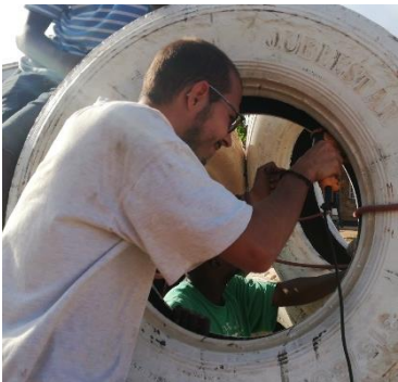
Ilustración 62: Taladrado unión pirámide. Fuente: Propia
