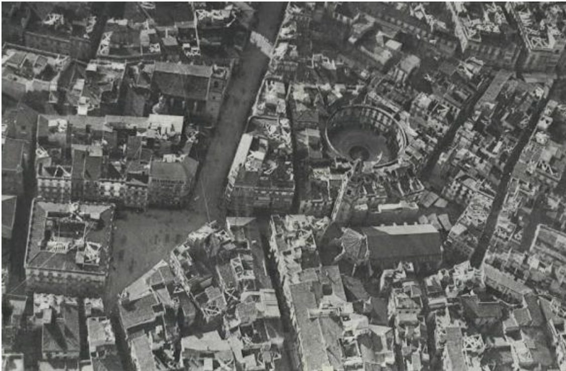
Img.nº3 Vista aérea de la Plaza de la Reina. 1930.
