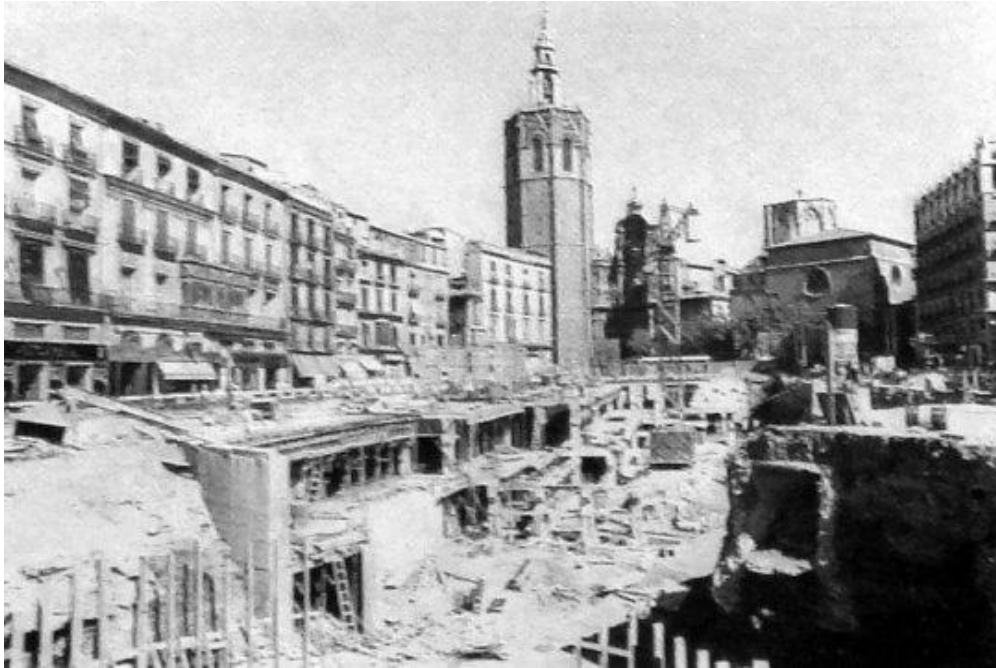
Img.nº23 Vaciado de la plaza de la Reina. 55
