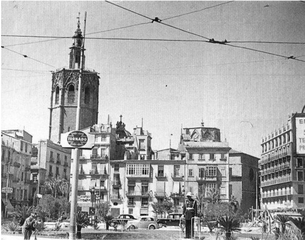
Img.nº18 Vista de la manzana aún sin derribar. 50
