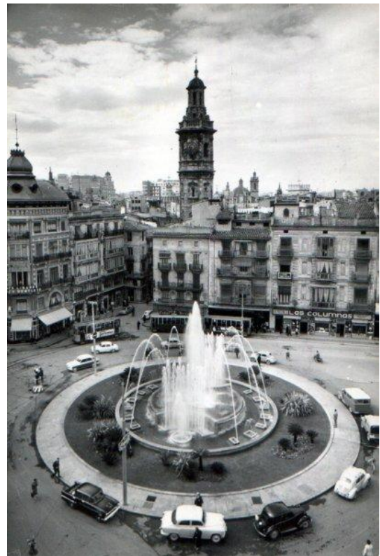
Img.nº17 Fuente luminosa. 48
