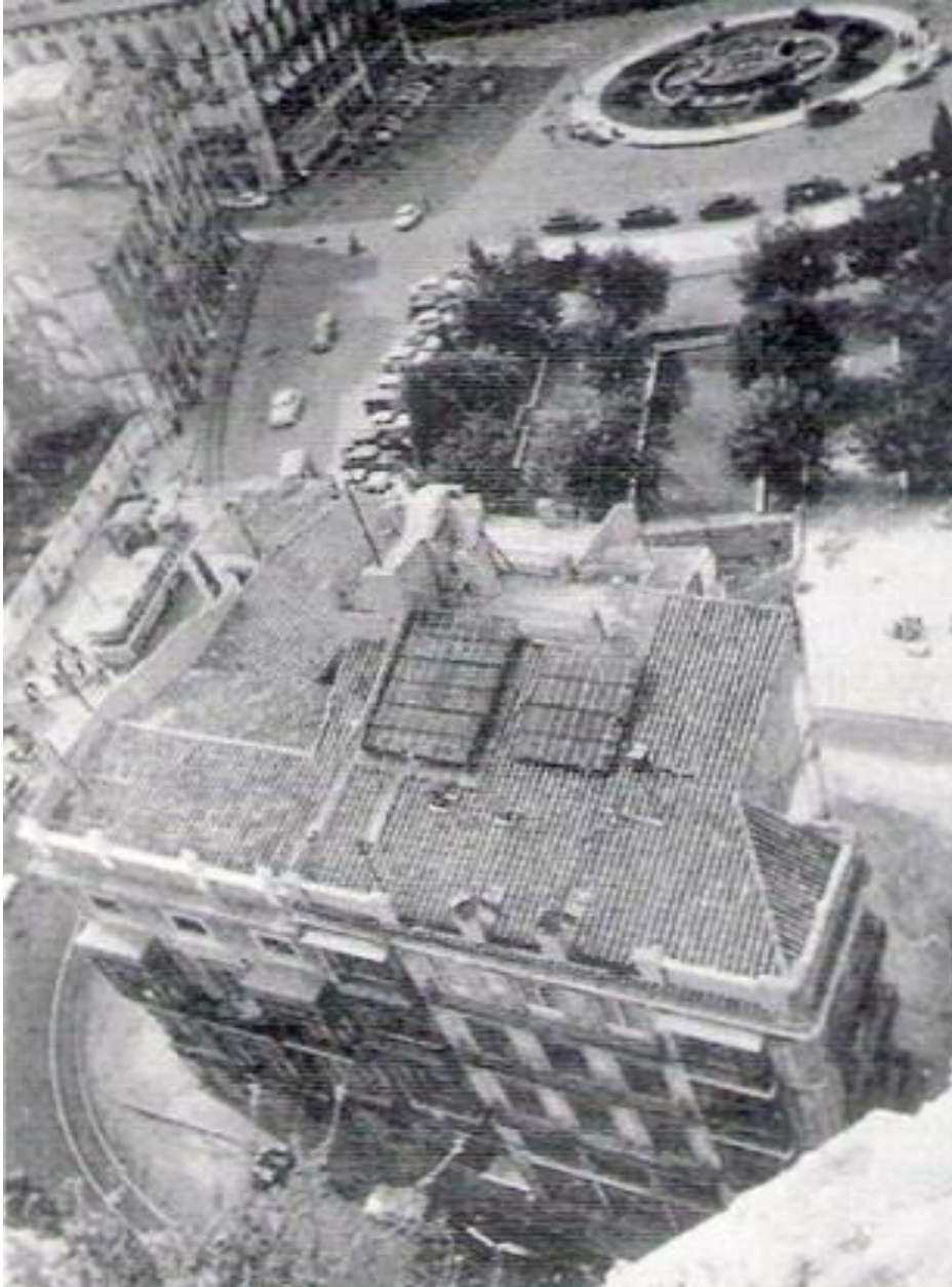
Img.nº21 Vista últimas viviendas a derribar principios de la década de los 60. 53
