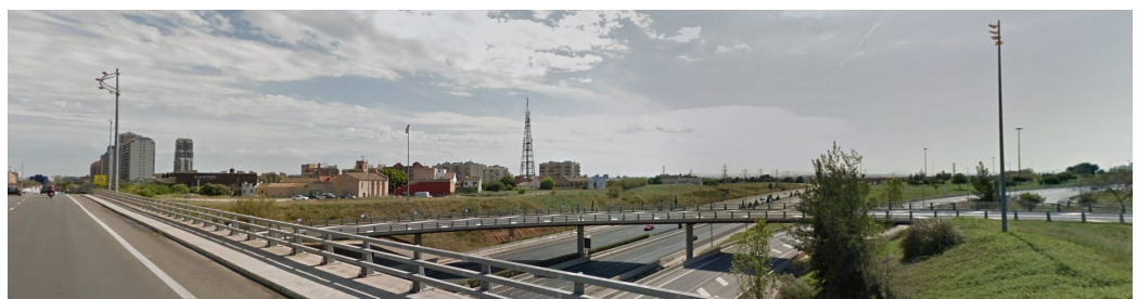
I. 204. Sud, primer pla: ronda CV30, a l'esquerra Beniferri i l'Avinguda de les Corts Font: GSV
