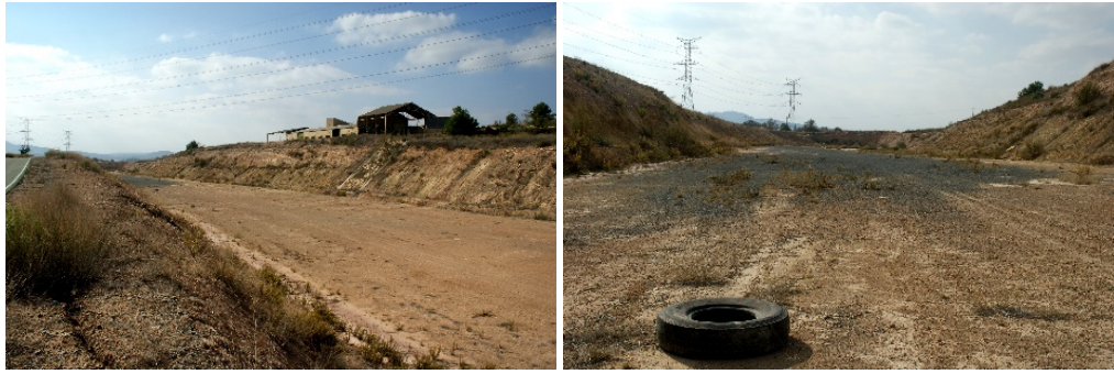
Il·lustració 235 i 236. Obres abandonades CV50. Font pròpia
