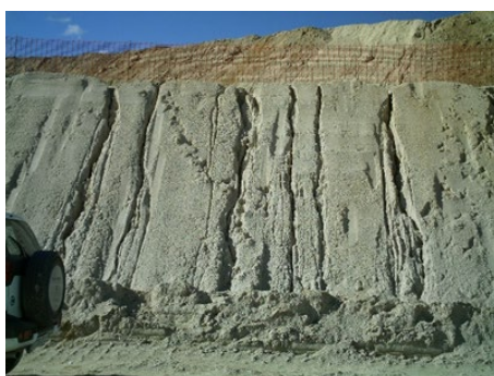
Il·lustració 21 Talús, obres ampliació CV35. Font pròpia
