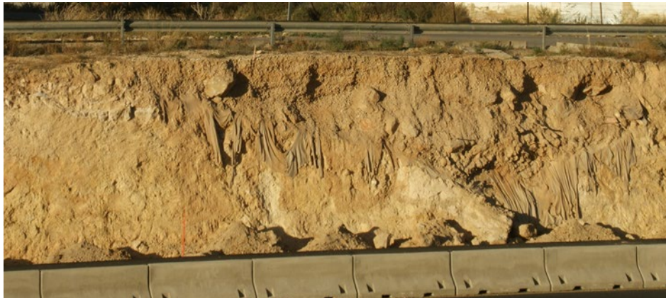
Il·lustració 234 Talús: Obres d'ampliació CV35, octubre 2020 Font pròpia
