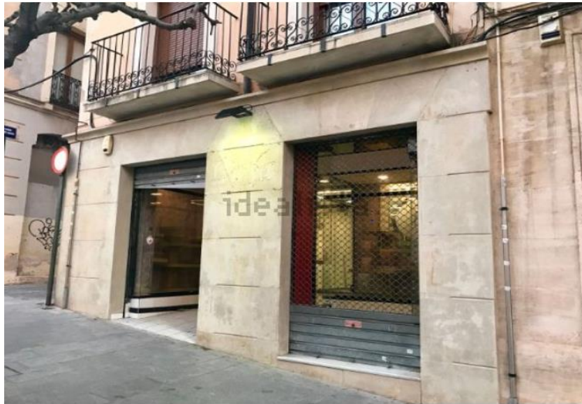
Ilustración 17: Fachada del local en Alcoy. Google Maps 2021.
