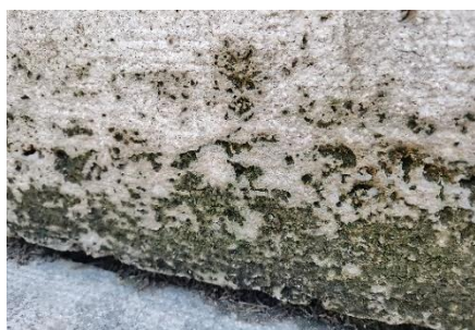
Figura 8. Las oquedades que presenta la superficie calcárea de la roca artificial sirven como espacio idóneo para el crecimiento de bacterias, hongos y como en la imagen, musgos.
