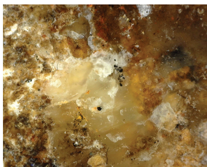
Figura 61. Detalle del desgaste de la madera, grietas y pérdida de soporte.
