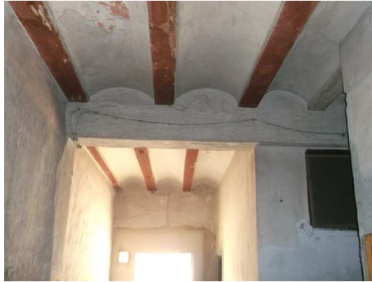
Forjado de techo de la vivienda nº 19
