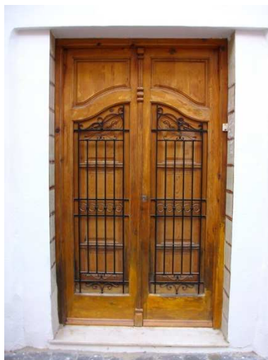
Puerta de acceso de las viviendas nº 15 y 17
