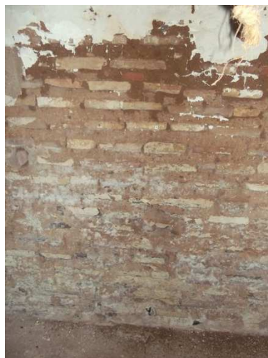
Muro de mampostería de la vivienda nº 19
