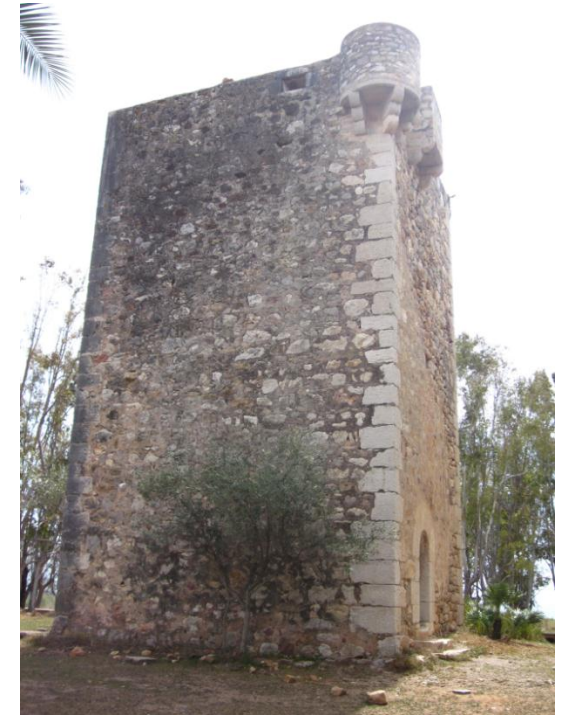
Fig. 18: Cara Oeste Torre la Sal (Cabanès)
