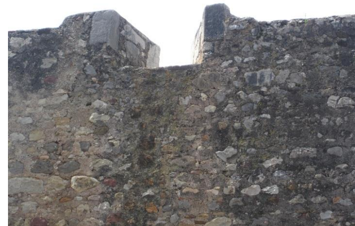
Fig. 22: Apertura en el muro o cañoneras.
