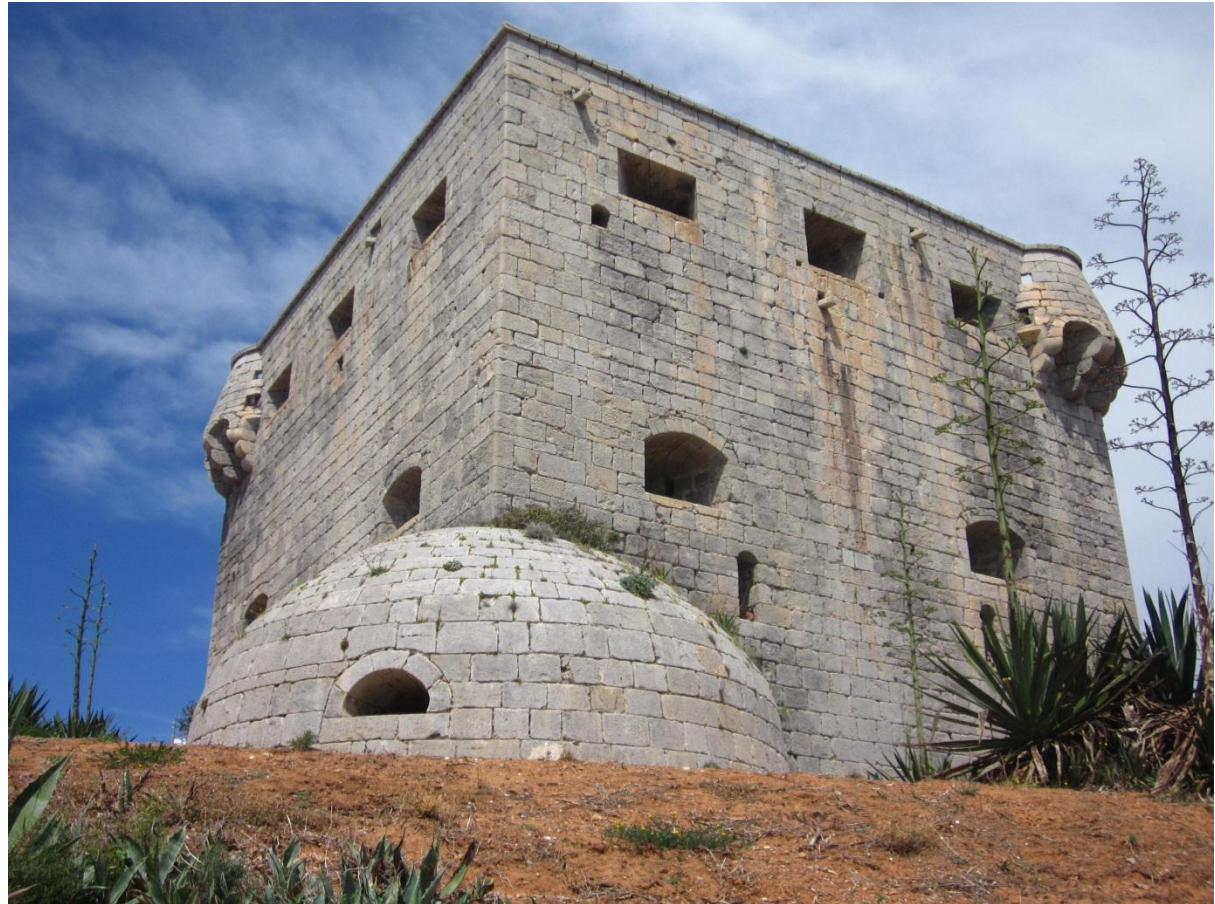
Fig. 38: Foto de la fachada que da al mar, de la Torre del Rei (Oropesa) 2012
