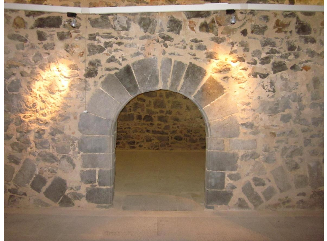
Fig. 33: Portal de piedra sillar y arquería de medio punto que divide dos espacios idénticos por un muro de 0,75 metros.
