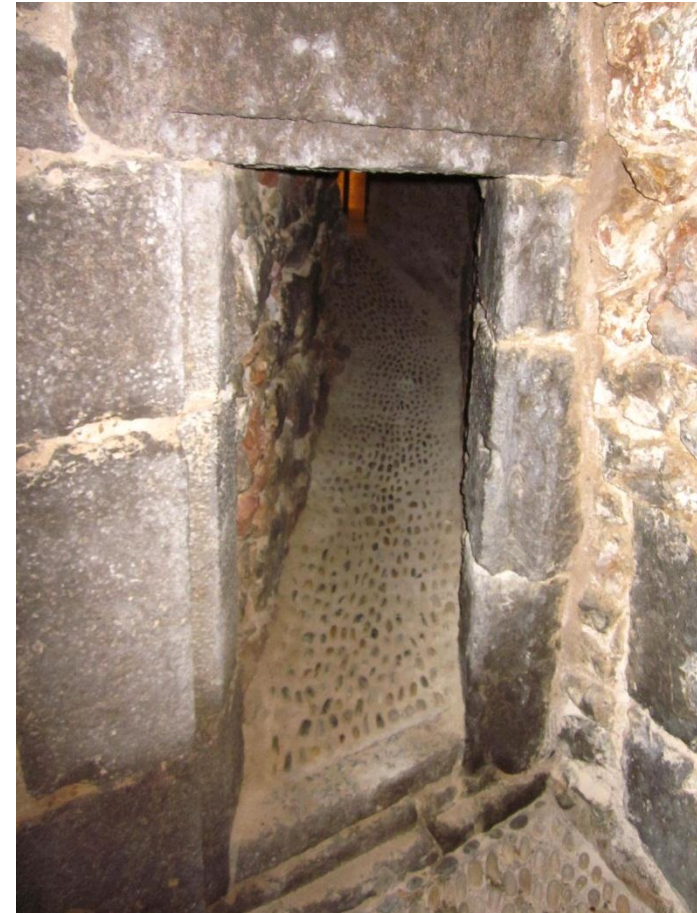
Fig. 30: Pasillo por el cual se accede a una de las dos caponeras que tiene La Torre del Rei. Estas caponeras eran de 5 m. de radio, con un espacio interno ovoide y tres troneras.
