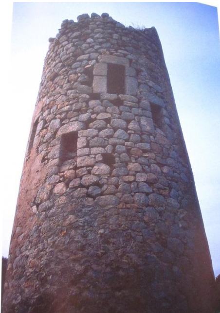
Fig. 44: Antigua Torre de la Cuerda
