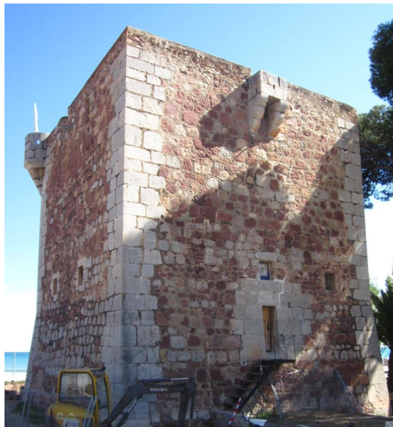
Fig. 55: Torre de San Vicente (Benicassim). Obra de un vallado perimetral, para proteger la torre, que es patrimonio de la provincia de Castellón.
