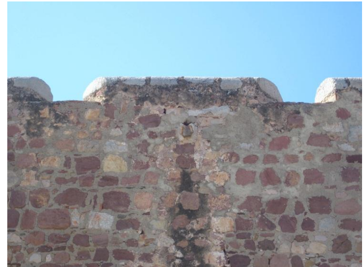
Fig. 64: Apertura en el muro o cañoneras.
