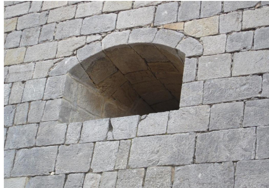
Fig. 28: Oropesa, Castelló. Torre del Rei. Detalle de la bocana abombada de una de las caponeras de la Torre. Obsérvese la perfección técnica de su trazado a base de cinco piezas arqueadas de las cuales una sirve de clave.
