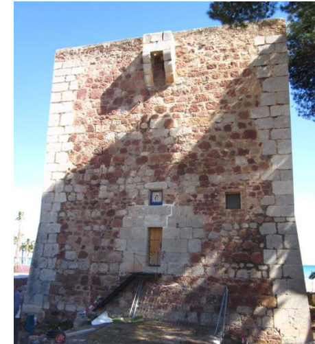
Fig. 60: Cara Oeste Torre Sant Vicent (Benicàssim)
