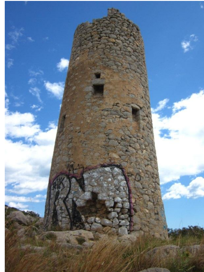
Fig. 54: Ejemplo de torre circular. En este caso, Torre de la Colomera.
