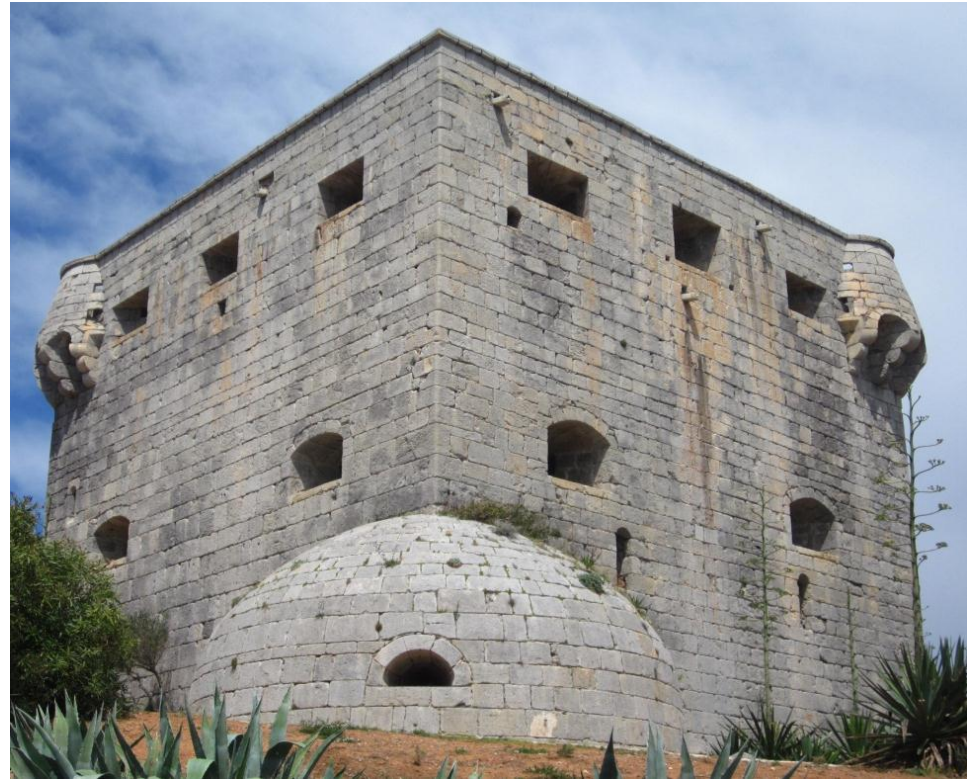
Fig. 24: Orpesa, Castelló. Torre del Rei. Puede observarse la grandiosidad de la obra de la Torre con sus dos plantas dispuestas para se artillada como demuestran claramente sus líneas de troneras. De ellas, unas con bocana abombada, otras de forma adintelada. En primer término robusta caponera o casamata y en lo alto de los ángulos laterales, los bellos garitones.
