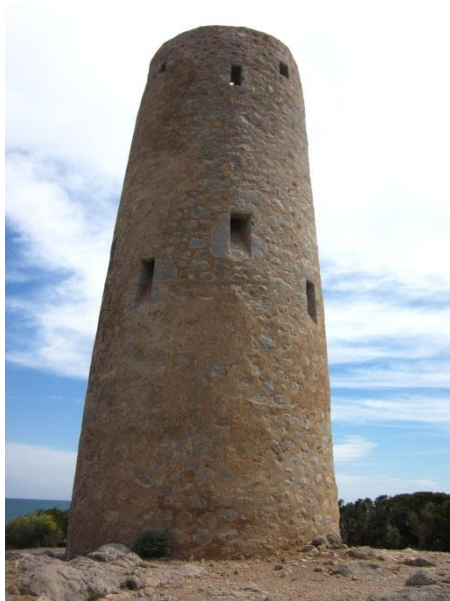
Fig. 42: Cara Sur. Torre de la Cuerda
