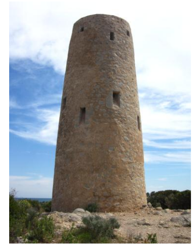
Torre de la Cuerda 3.3
