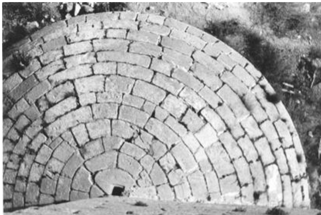
Fig. 32: Orpesa, Castelló. Torre del Rei. Caponera del N-O vista desde lo alto de la torre en la cual puede observarse perfectamente la forma de construcción: la trampilla de ventilación de la misma, en su parte más alta, junto al muro de la Torre y los distintos desperfectos motivados por sendos disparos de la artillería francesa del General Souchet en 1811.
