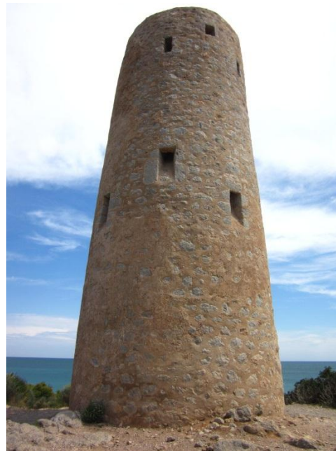
Fig. 45: Torre de la Cuerda, restaurada
