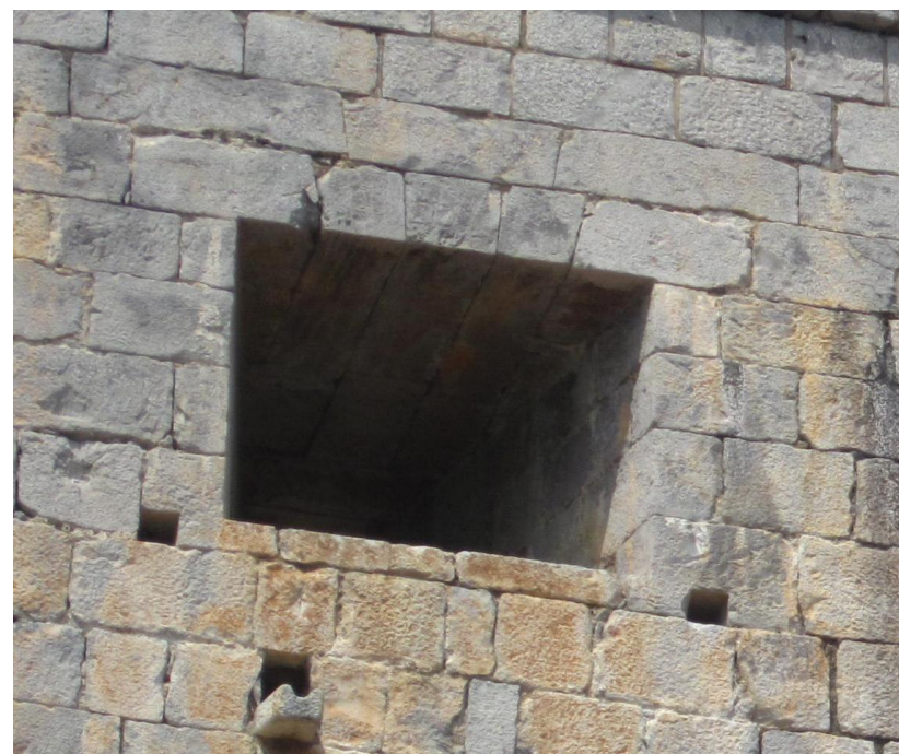
Fig. 31: Detalle de la bocana rectangular de una de fachadas de la Torre. Obsérvese la perfección técnica de su trazado.
