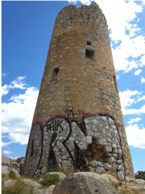
Fig. 49: Cara Sur. Torre de la Cuerda
