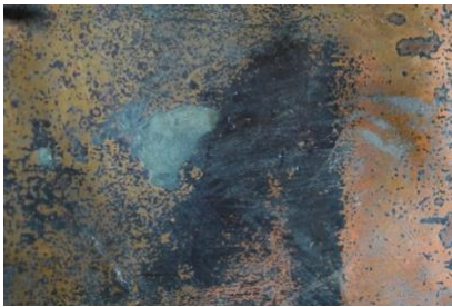
Fig. 20. Detalle de las manchas y acumulaciones de suciedad.
