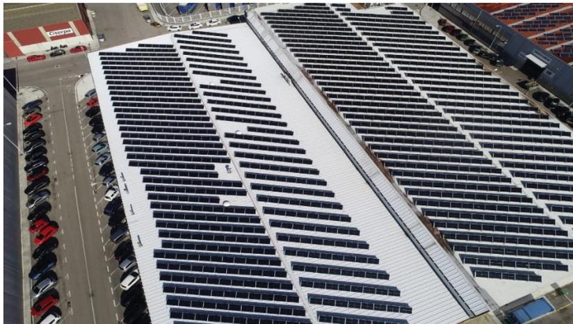
Figura 11: Instalación fotovoltaica para el autoconsumo en Iberconsa
