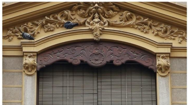
Imágenes de lambrequines de madera pertenecientes a los barrios de Ruzafa y el Carmen de Valencia. Fotografías de autor
