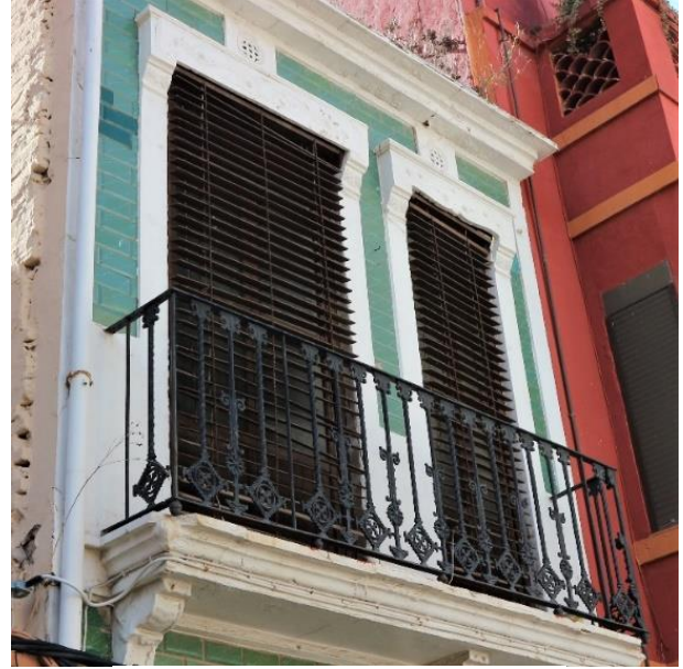
Calle Barraca 265. Fotografía de autor
