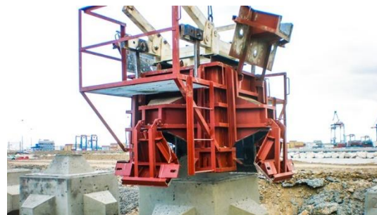
Figura 7.36. Encofrado del Cubípedo. Fuente: Web del Cubípedo.
