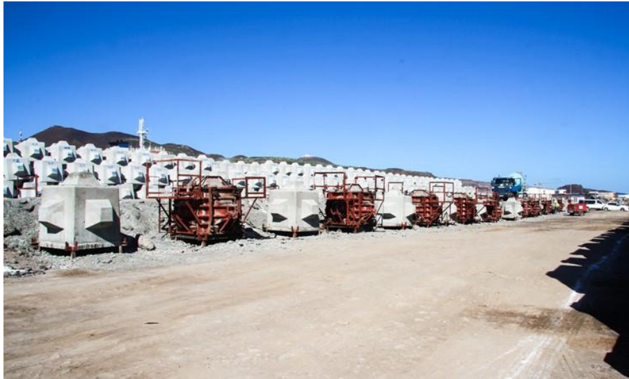
Figura 7.37. Hormigonado de los Cubípodos en obra. Fuente: Web del Cubípodo.
