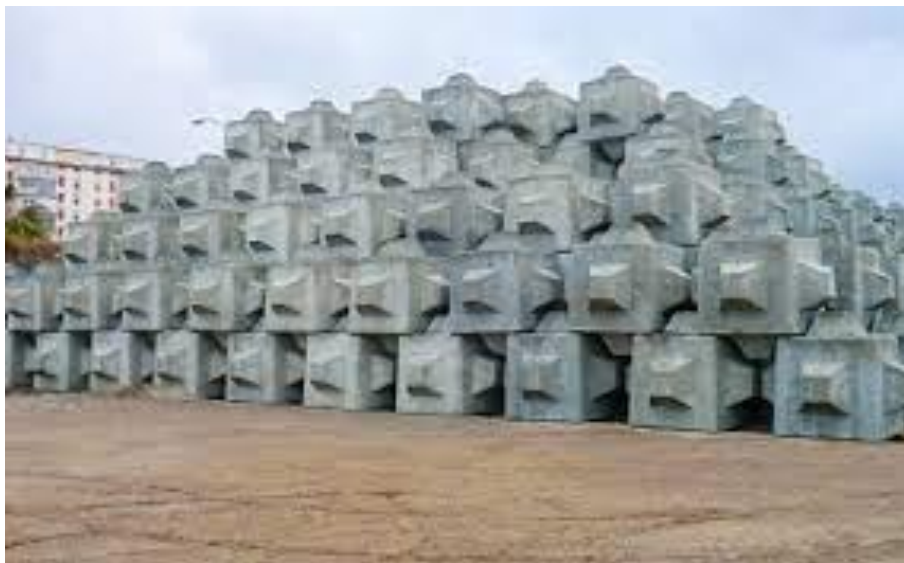
Figura 2.9. Acopio de Cubípodos. Fuente: Web del Cubípedo.
