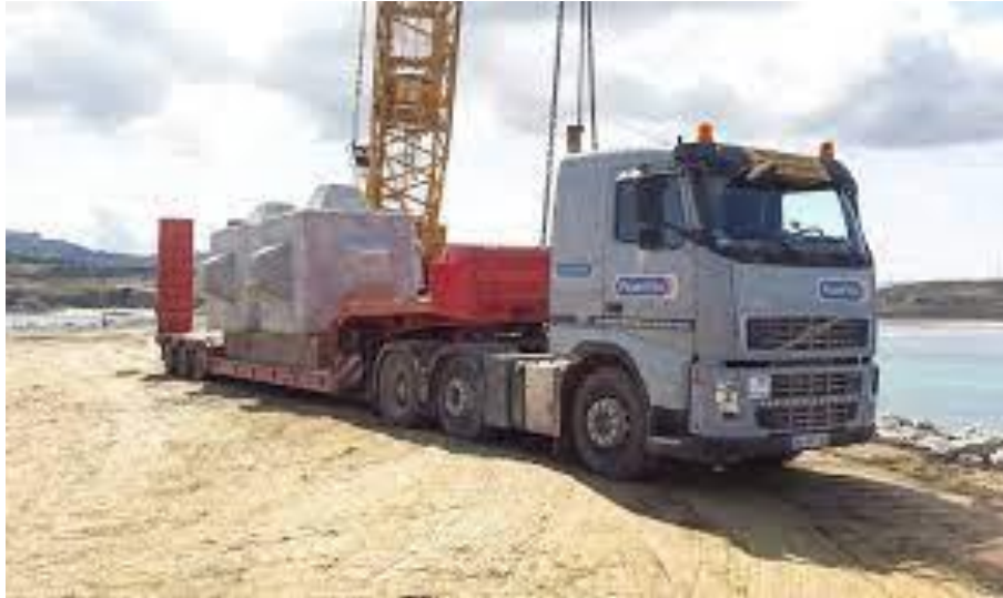
Figura 2.10. Transporte de Cubípedo en camión. Fuente: Medina y Gómez-Martín (2016).
