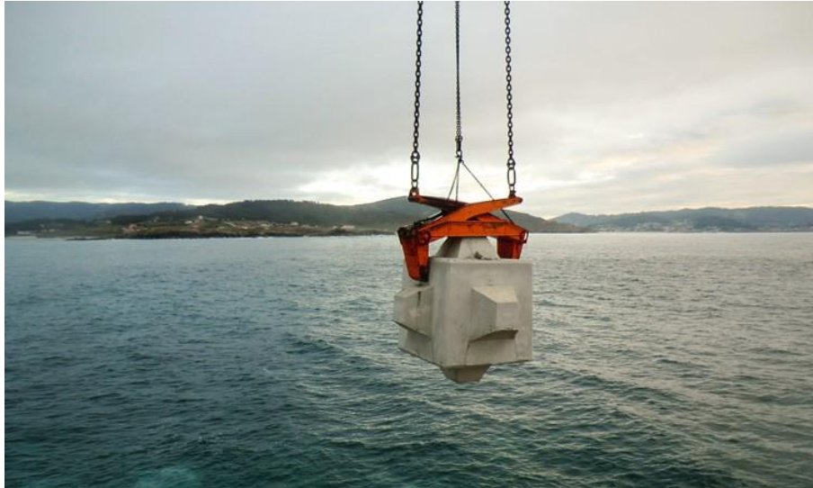
Figura 7.40. Colocación de Cubípedo en obra. Fuente: Web del Cubípedo.
