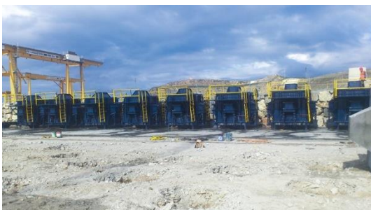
Figura 7.36. Encofrado del Cubípedo. Fuente: Web del Cubípedo.
