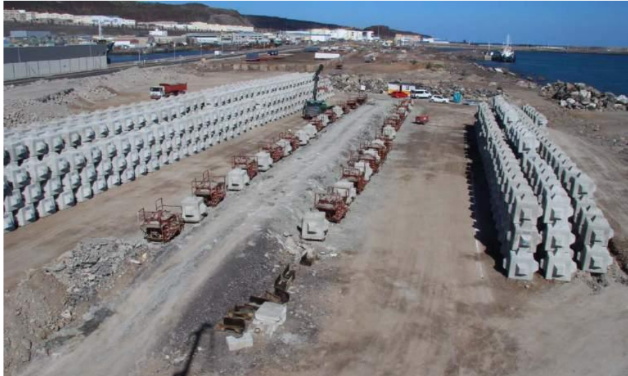
Figura 7.39. Parque de fabricación y acopio de Cubípodos. Fuente: Web del Cubípedo.
