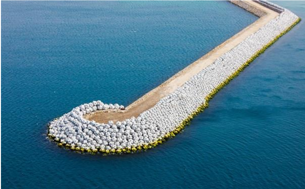
Figura 2.8. Contradique de Langosteira II. Fuente: Web del Cubípedo.
