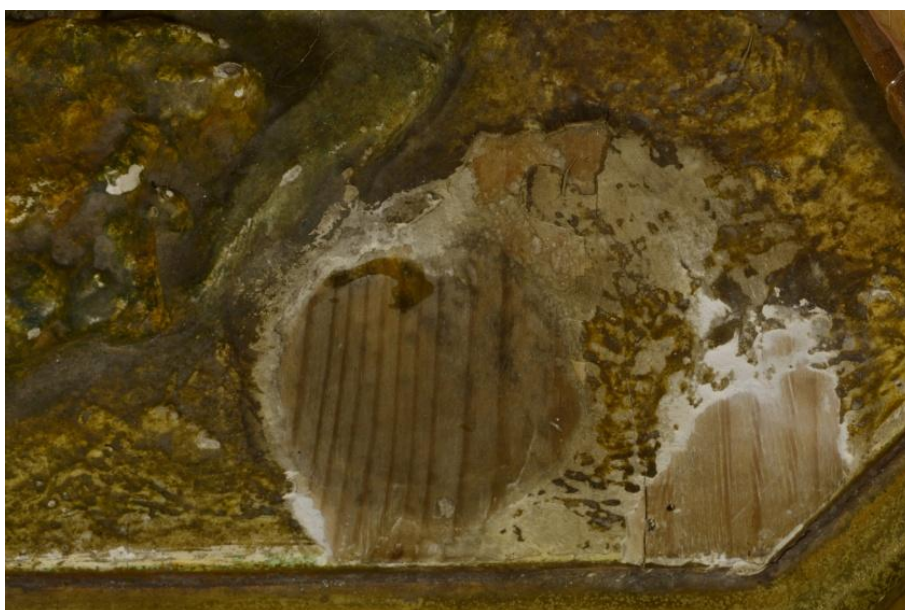
Figura 49. Abrasión y faltante de los diferentes estratos de la yesería de la peana.
