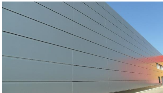
Ilustración 1-23. Fachada tipo sándwich. Procedencia: https://bobetcanarias.com/paneles-de-sandwich-en-tenerife/
