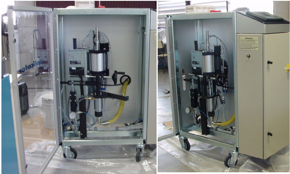
Figura 47.- Equipo de inyección
