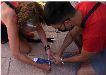
Fig.28 Muntatge de la instal·lació 3.
