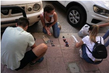
Fig.27 Muntatge de la instal·lació 2.
