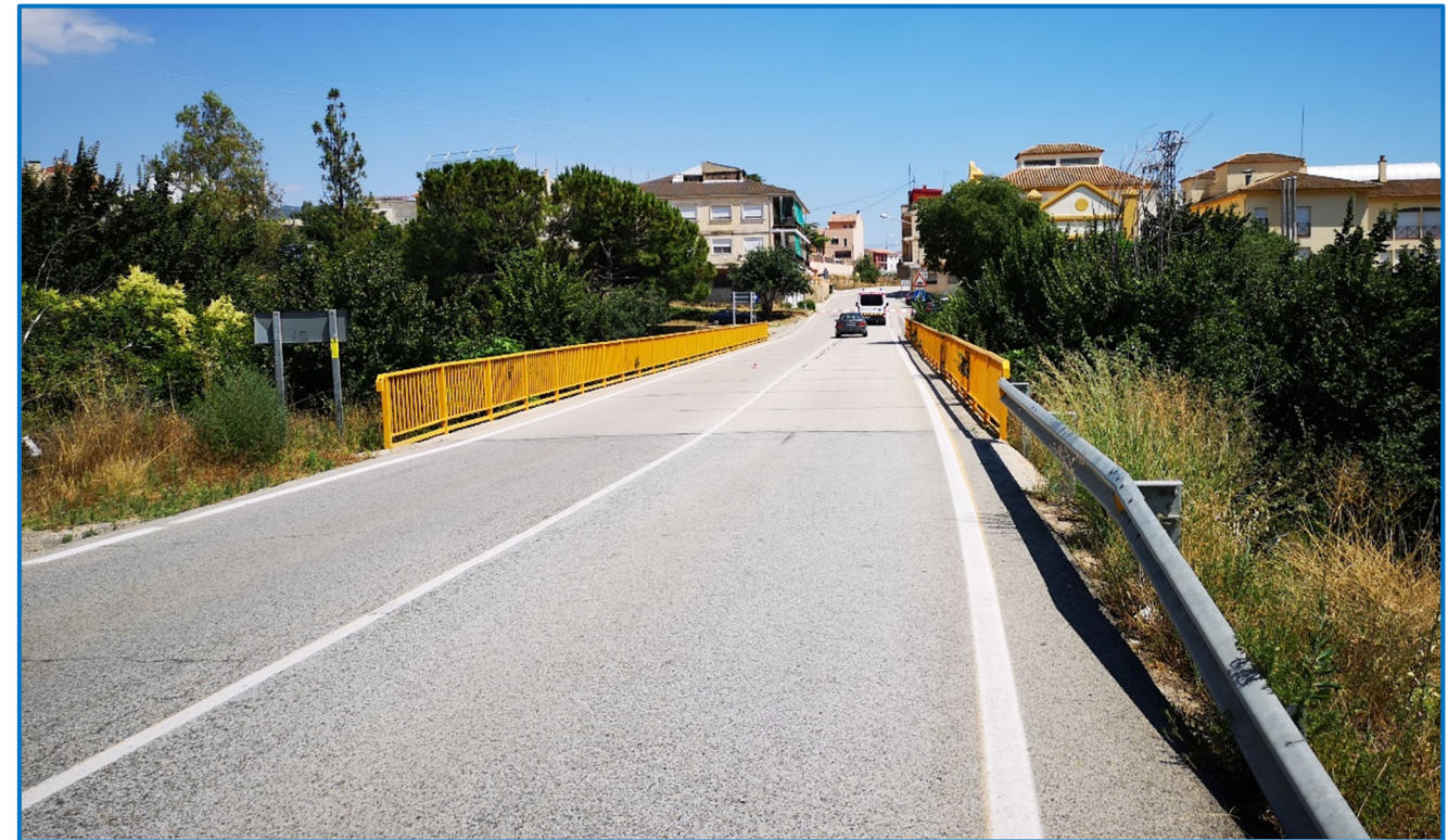
Imagen 1. Estructura sobre el barranco del Montú.
