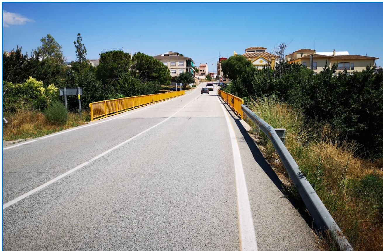
Imagen 11. Estado estructura existente sobre barranco.
