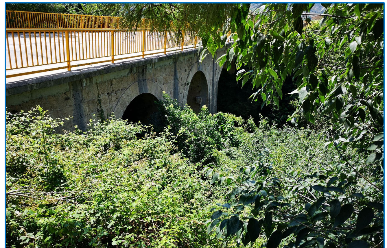
Imagen 9. Estructura existente sobre el barranco
