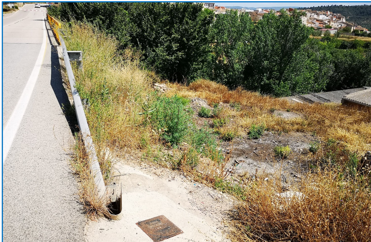
Imagen 6. Vista oeste de la localización de la futura pasarela.
