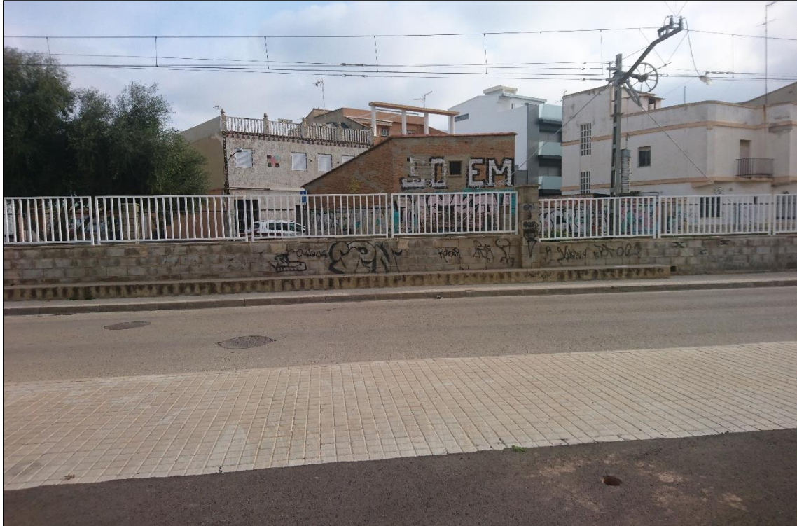
Fotografía 4. En frente se ubicará el acceso al paso inferior desde la C/Isabel de Villena. Al otro lado de la vía, donde se sitúa esa edificación, se ubicará el acceso desde la C/València. Sondeo 1 abajo a la derecha.
