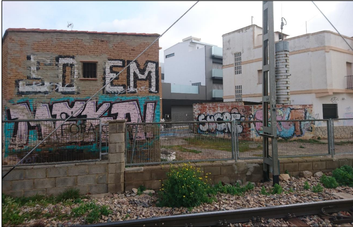
Fotografía 8. Parcela y edificación donde se situará el acceso al paso inferior en la C/València. Vista desde la C/Isabel de Villena.
