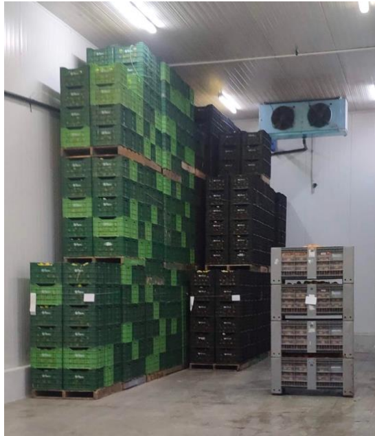
Figura 4.7. Apilado en bloque dentro de la cámara frigorífica (ToñiFruit, 2021)
