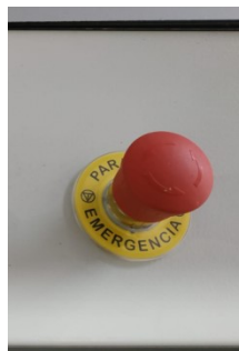
FIGURA12 -Parada de emergencia 1
