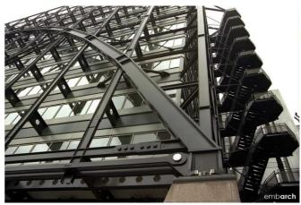
Figura 3.2-3. Uniones atornilladas de los elementos estructurales metálicos. Fuente: (London-Exchange House-EmbArch, n.d.)
