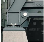
Figura 4.3-9. Tirante tipo A. Fuente: (SOM | Broadgate-Exchange House, n.d.)
