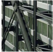
Figura 4.3-8. Tirantes tipo B y C. Fuente: (SOM | Broadgate-Exchange House, n.d.)
