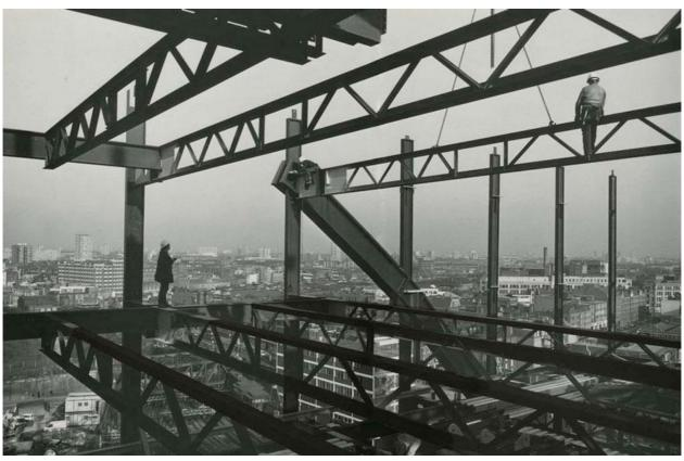
Figura 3.2-6. Colocación de las vigas en celosías de los vanos exteriores. Fuente: John Davies. (A closer look at SOM's AIA Twenty-Five Year Award-Winning Broadgate Exchange House, n.d.)
