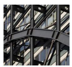
Figura 3.1-15. Encuentro arco con pilares y tirantes. Fuente: (NICK GUTTRIDGE-SOM-Broadgate, n.d)
