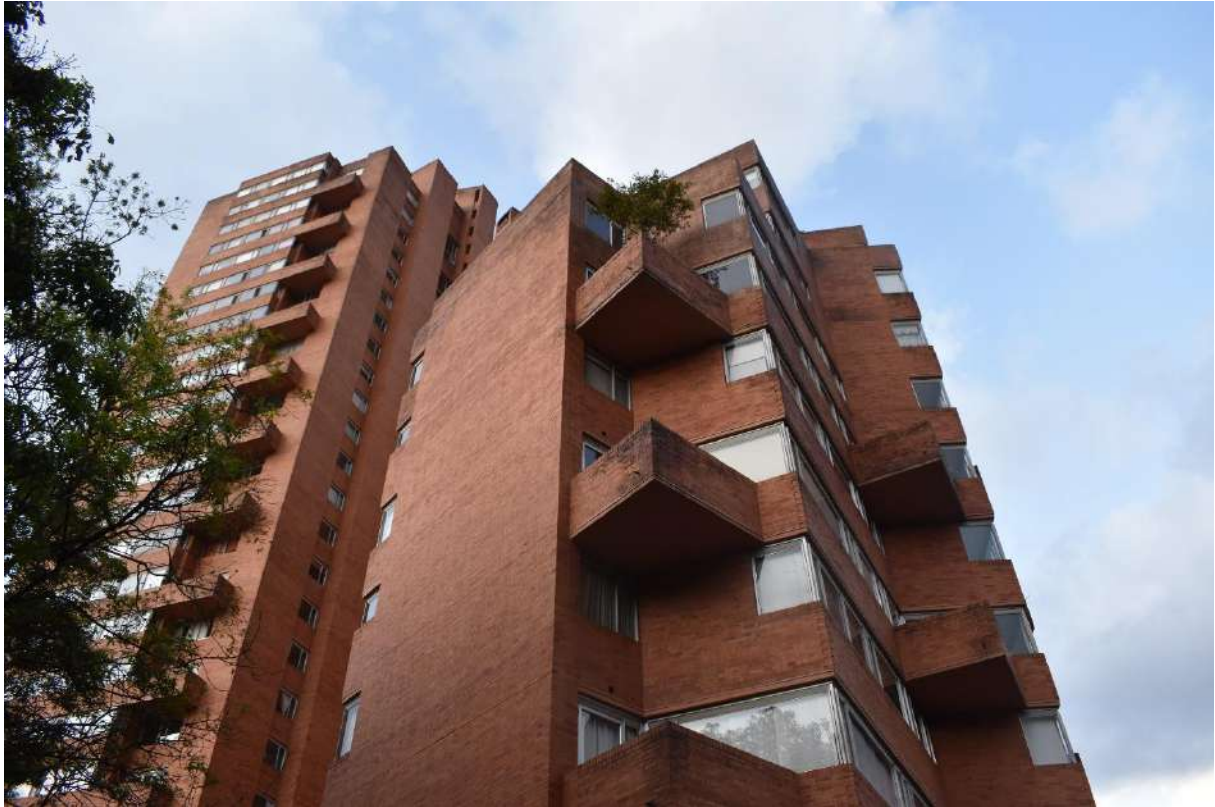
Figura 42. Fotografía exterior Torres del Parque. Fuente: Autora (2021).
