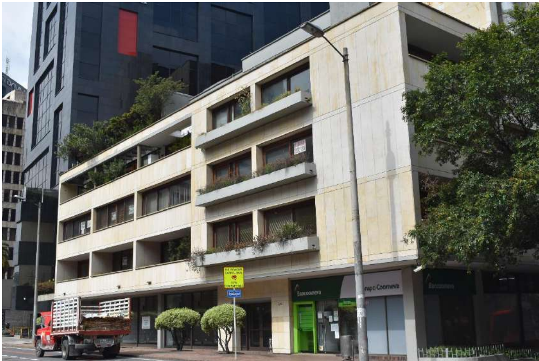
Figura 67. Fotografía exterior Edificio Rueda. Fuente: Autora (2021).
