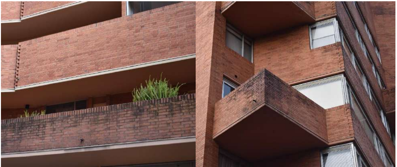
Figura 43. Fotografía detalles exteriores estado actual Torres del Parque. Fuente: Autora (2021).
