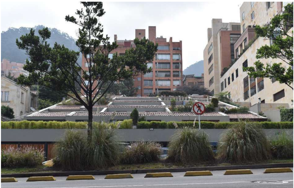
Figura 62. Fotografía exterior Multifamiliar Escalonado Gerona. Fuente: Autora (2021).
