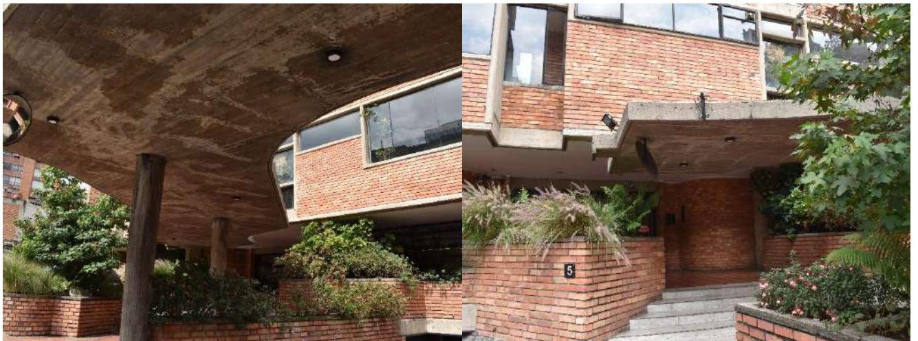
Figura 69. Fotografía detalles exteriores Edificio Giraldo. Fuente: Autora (2021).
