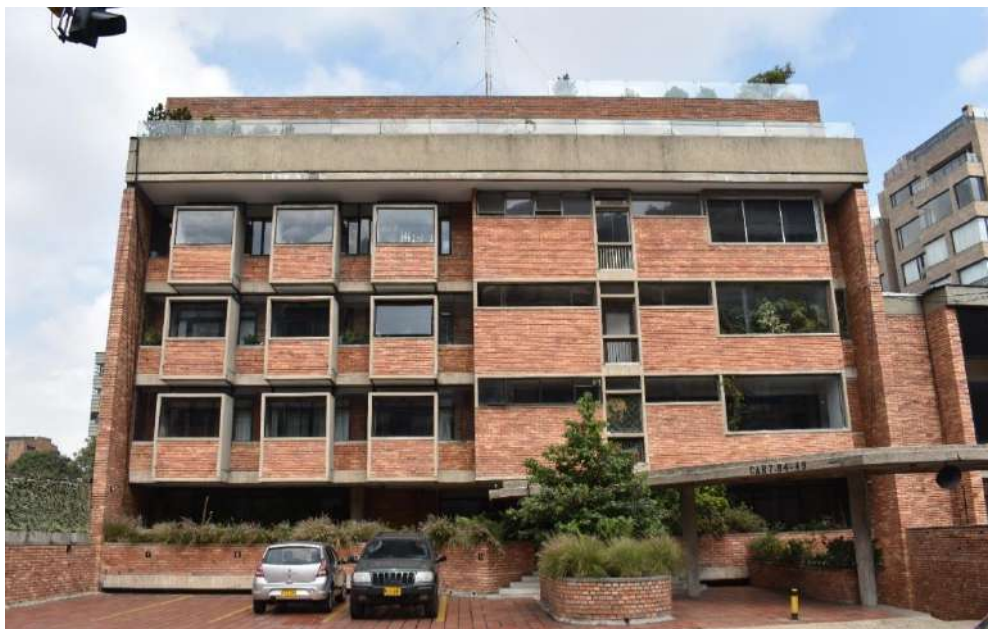
Figura 70. Fotografía exterior Edificio Giraldo. Fuente: Autora (2021).
