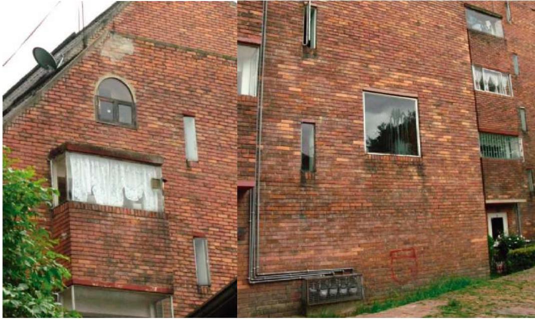
Figura 57. Fotografías detalles exteriores estado actual Fundación Cristiana de la Vivienda San Cristóbal. Fuente: Aschner, J. (2018).
