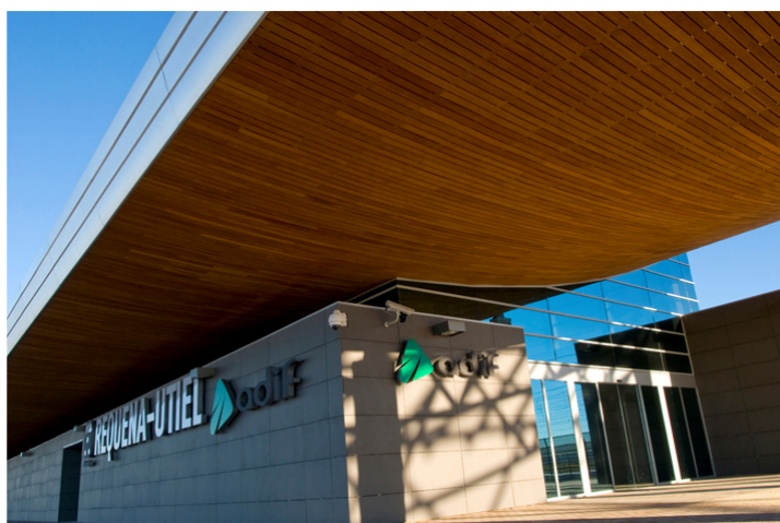
Imagen 1. Estación de Requena-Utiel. Fuente: ADIF.
