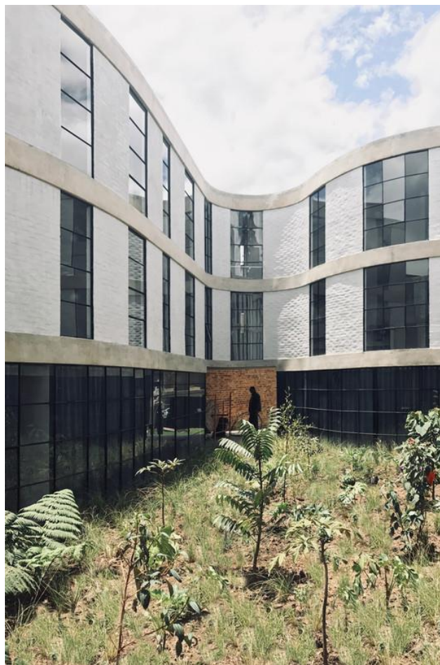
FIG. 1.2-4 Imagen del primer edificio ubicado de izquierda a derecha en el plano de localización (Ott, 2019).
