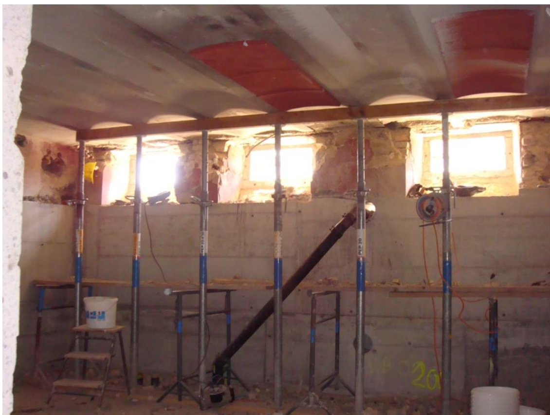
Ilustración 100, Tramo de ventanas y la reparación de las zonas de dinteles Fuente: Archobau, Dirección de obra
