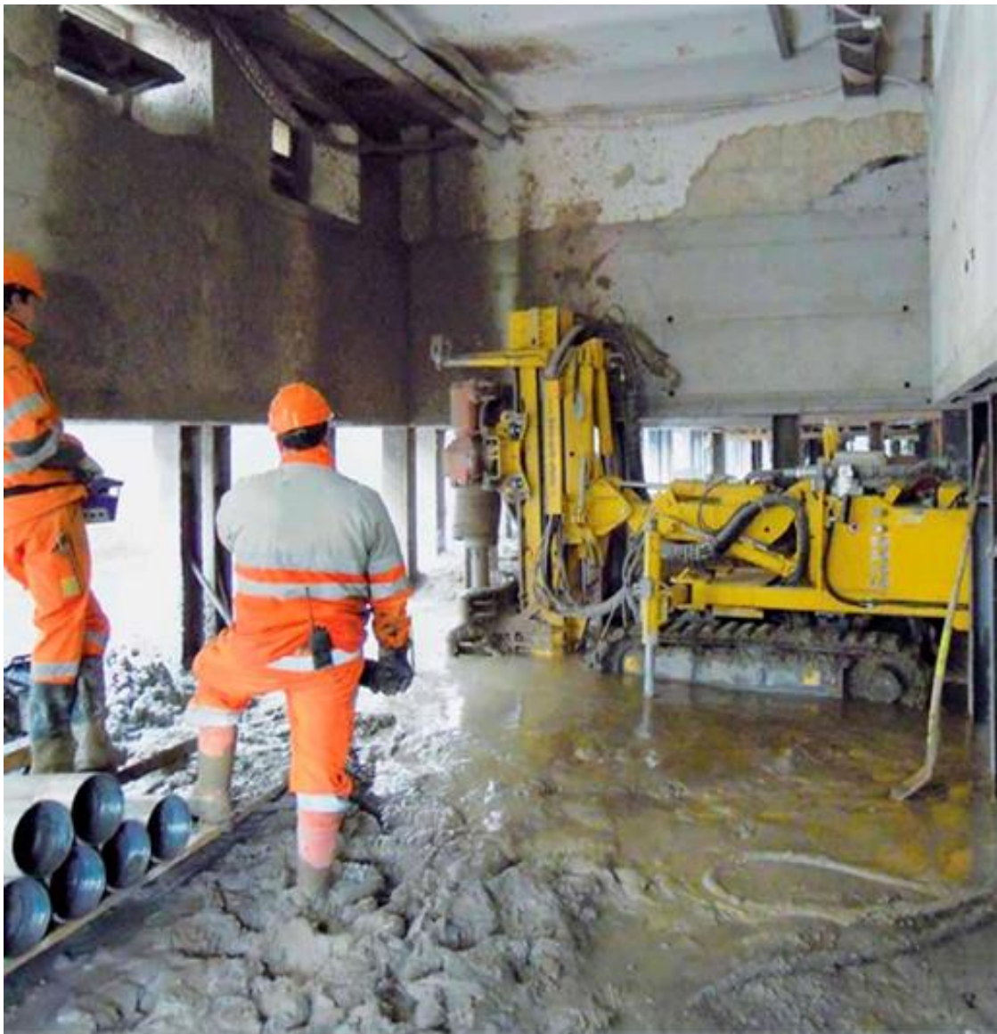
Ilustración 83, Trabajos de micropilotaje in situ Fuente: Archobau, dirección de obra, Zúrich
