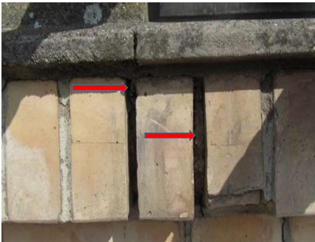
Ilustración 108, Falta de mortero en juntas de fabrica bajo el alfeizar Fuente: ídem Ilustración 74
