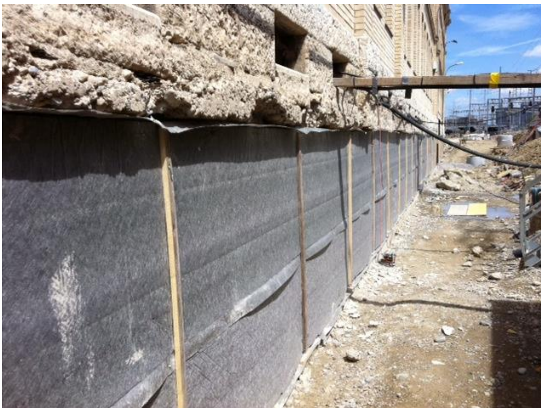
Ilustración 192, muro perimetral, sellado y protegido con geotextil, listo para relleno Fuente: Archobau, Zurich, dirección de obra
