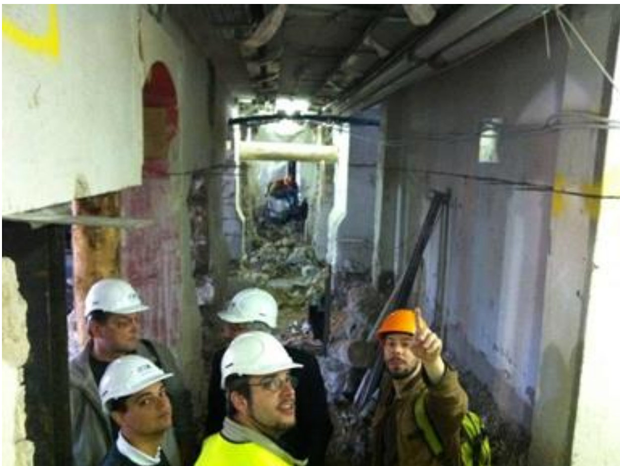
Ilustración 127, visita in situ del estado de los trabajos en la obra Fuente: Archobau, Zúrich, dirección de obra
