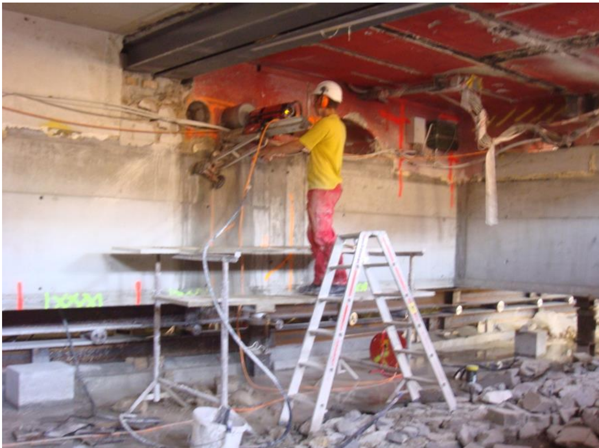
Ilustración 101, Perforaciones en muros para nuevas vigas de acero Fuente: Archobau, dirección de obra
