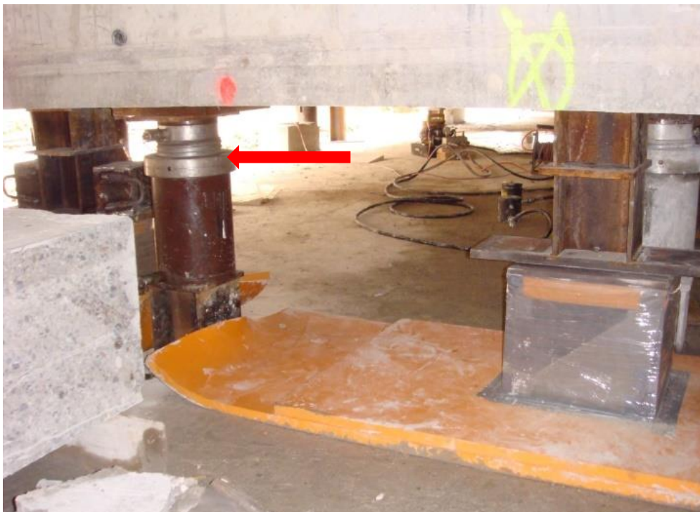
Ilustración 186, Prensas provisionalmente soportando el edificio Fuente: Archobau, Zúrich, dirección de obra
