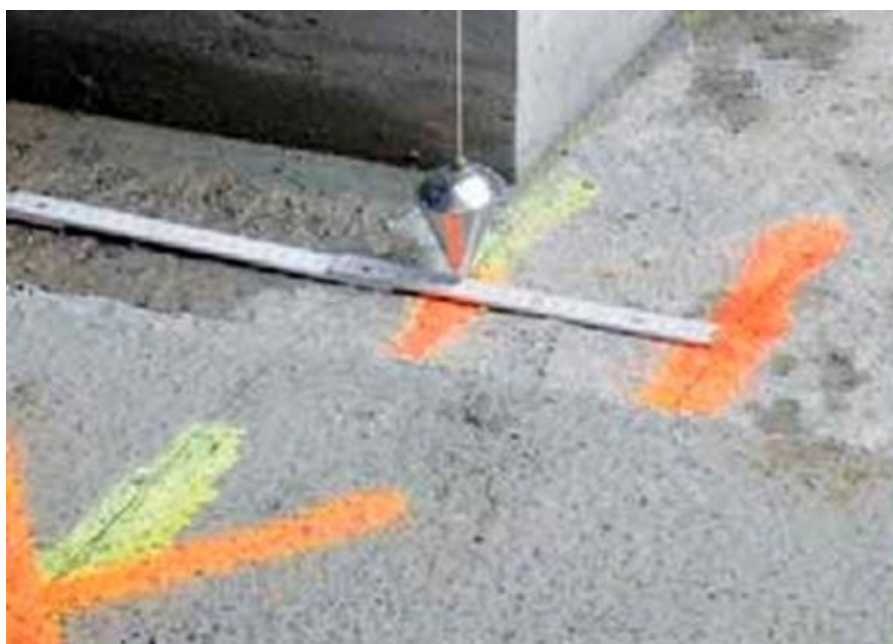
Ilustración 183, Punto de control in situ, nuevo emplazamiento Fuente: Archobau, Zurich, dirección de obra
