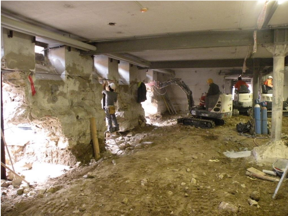
Ilustración 1265, trabajos manuales y con maquinaria en el muro perimetral Fuente: Archobau, Zúrich, dirección de obra
