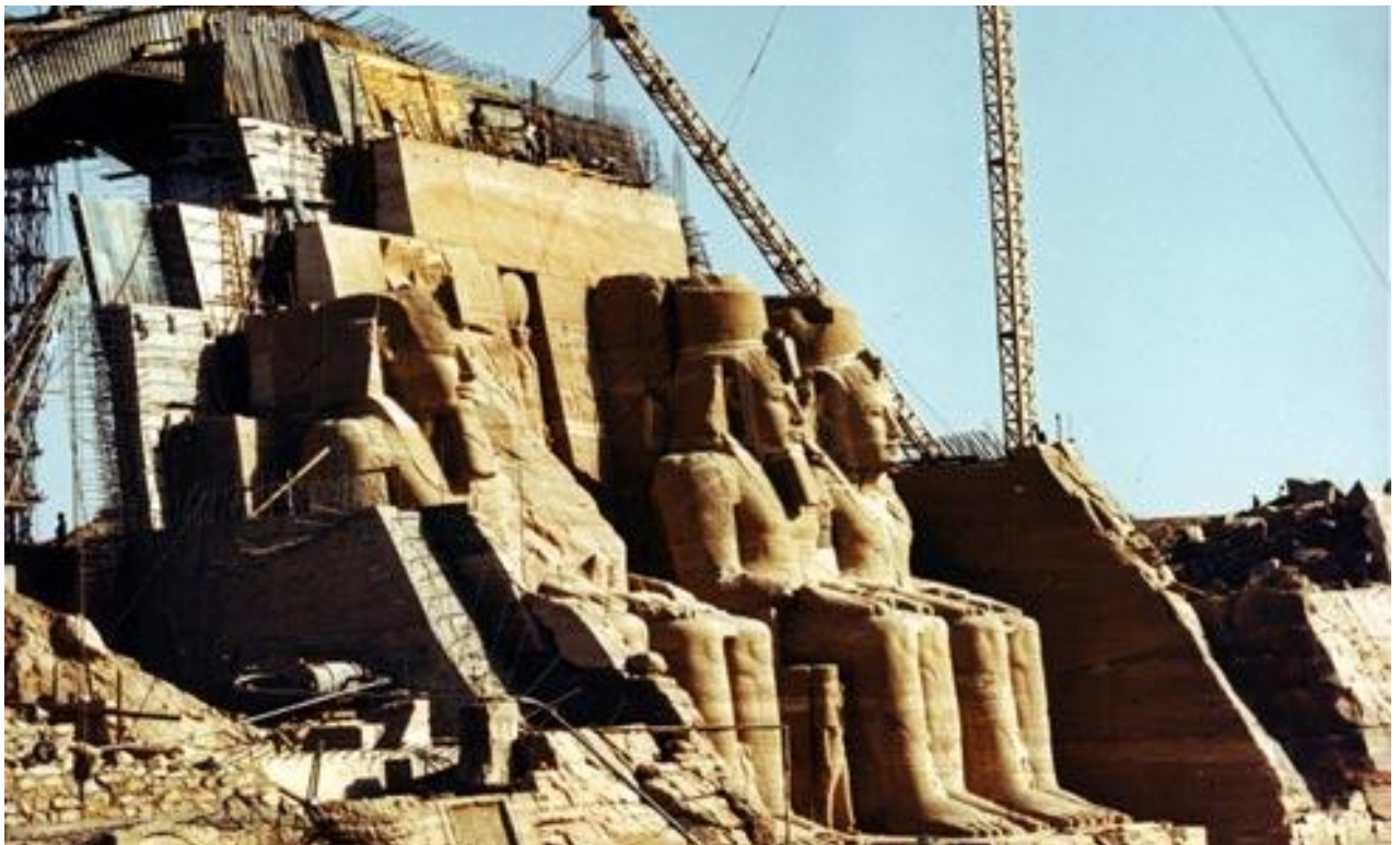
Ilustración 18, Estructura portante de hormigón, para soporte de las estatuas
