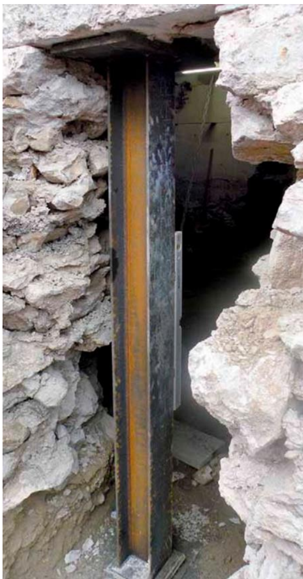
Ilustración 139: Nuevo Pilar introducido en muro existente Fuente: Henauer & Gugler Ingenieros, Zürich
