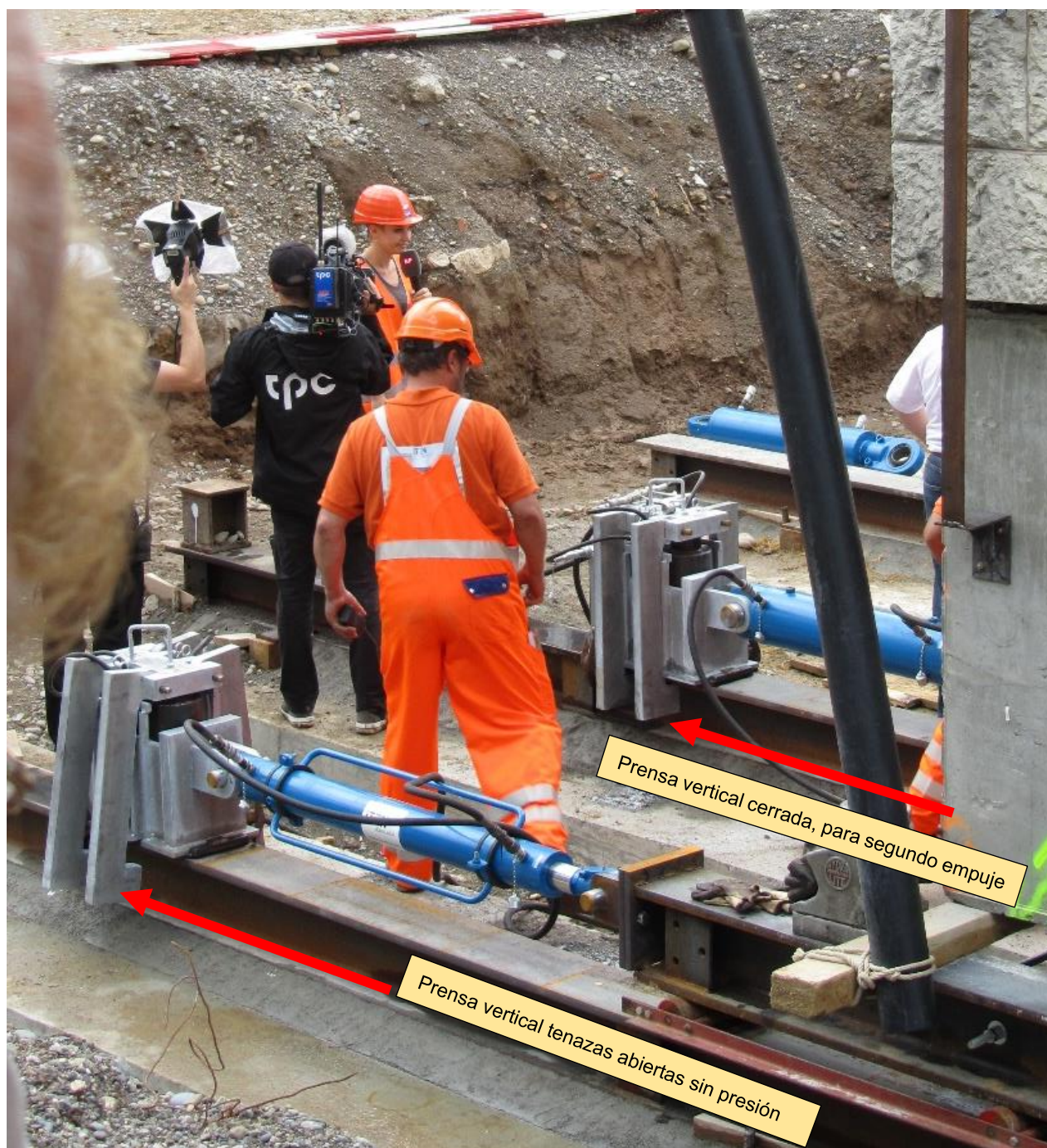
Ilustración 171, el primer empuje ya realizado Fuente: Henauer & Gugler, Ingenieros, Zúrich
