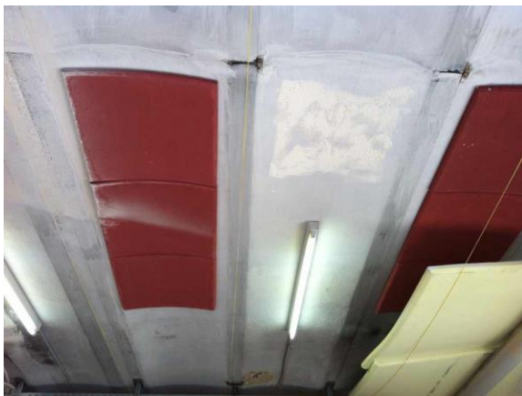
Ilustración 97, MFO sótano forjado Fuente Archivo Archobau, dirección de obra
