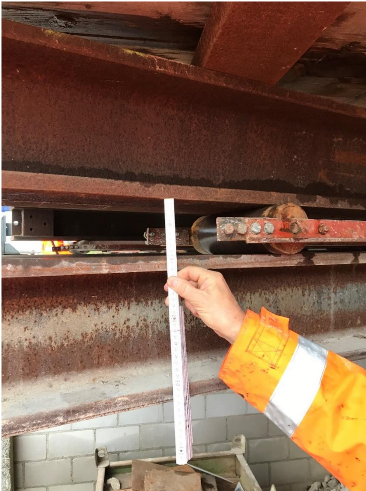
Ilustración 216, Comprobación rodillos y carriles
