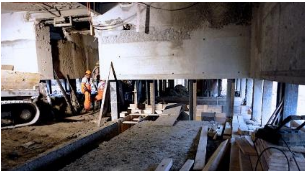
Ilustración 150, Base cimentación de carriles interior Fuente: Archobau,Zurich, dirección de obra
