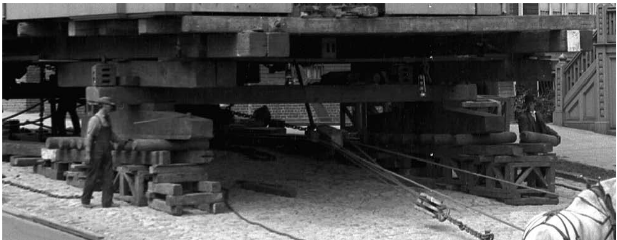
Ilustración 7, Detalle de rodillos y tablero móvil
