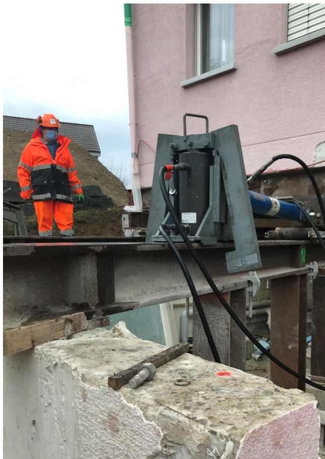
Ilustración 181, Tenazas hidráulicas abiertas sin presión, traslado edificio Schötz Fuente: Autor
