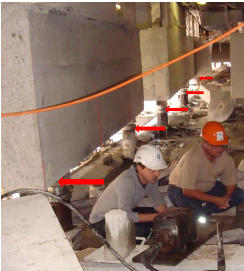
Ilustración 189, control de apoyos, Ingenieros HEGU, y constructor ITEN, Apoyo sobre Prensas Fuente: Henauer & Gugler, Ingenieros, Zúrich
