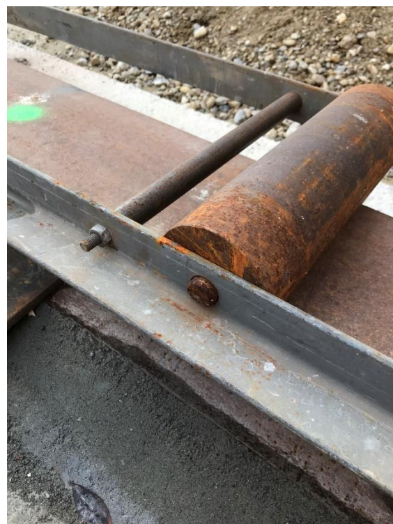
Ilustración 168, Rodillos con estabilizador y guías Fuente: Autor
