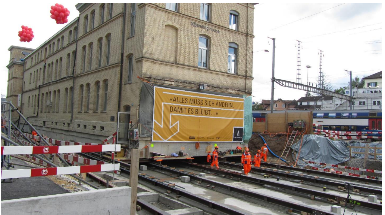
Ilustración 156, Edificio preparado para su traslado Fuente: Henauer & Gugler, Ingenieros, Zürich
