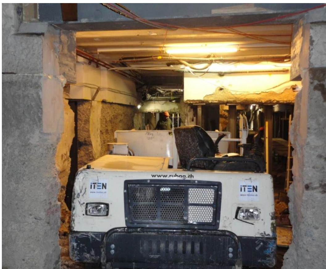
Ilustración 123, Apertura en fachada, para la introducción de maquinaria Fuente: Archobau, Zúrich, dirección de obra
