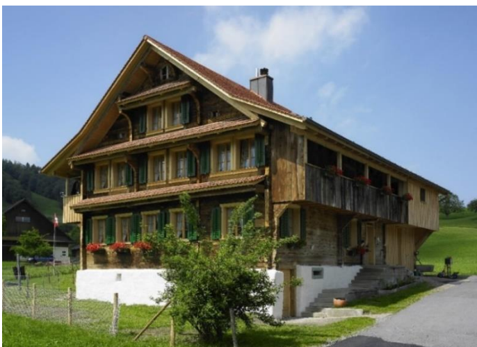
Ilustración 49, Imagen de la casa, reahilitada Fuente: Brigitte Moser y Anette Bieri, Mittelalterlicher und frühneuzeitlicher Ständer- und Blockbau in der Zentralschweiz , p 70 / 71, construcción con madera en la época gótico tardío
