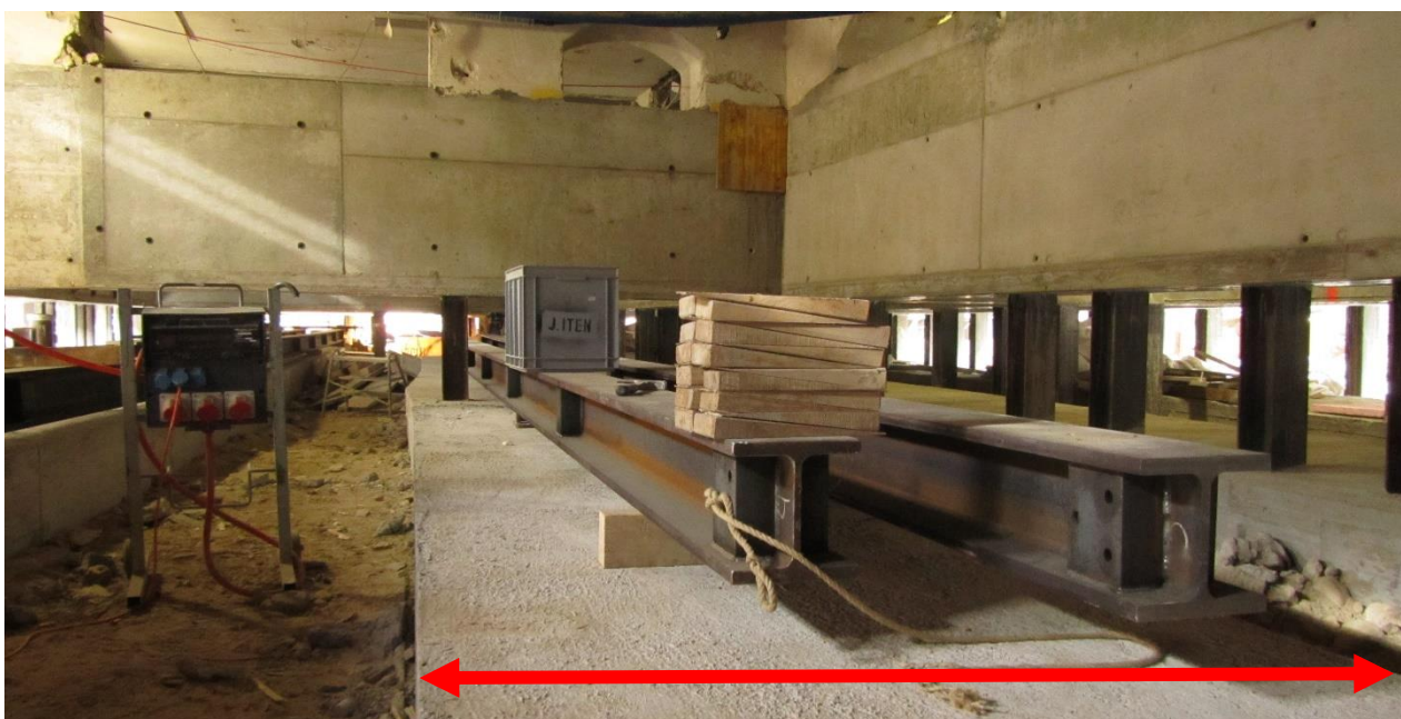
Ilustración 149, Cimentación para las vías de carriles Fuente: Archobau, Zúrich, dirección de obra
