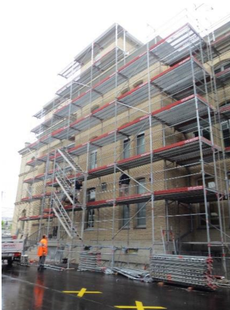
Ilustración 102, Fachada andamiada, después del traslado Fuente: Archobau, Dirección de obra, Zúrich
