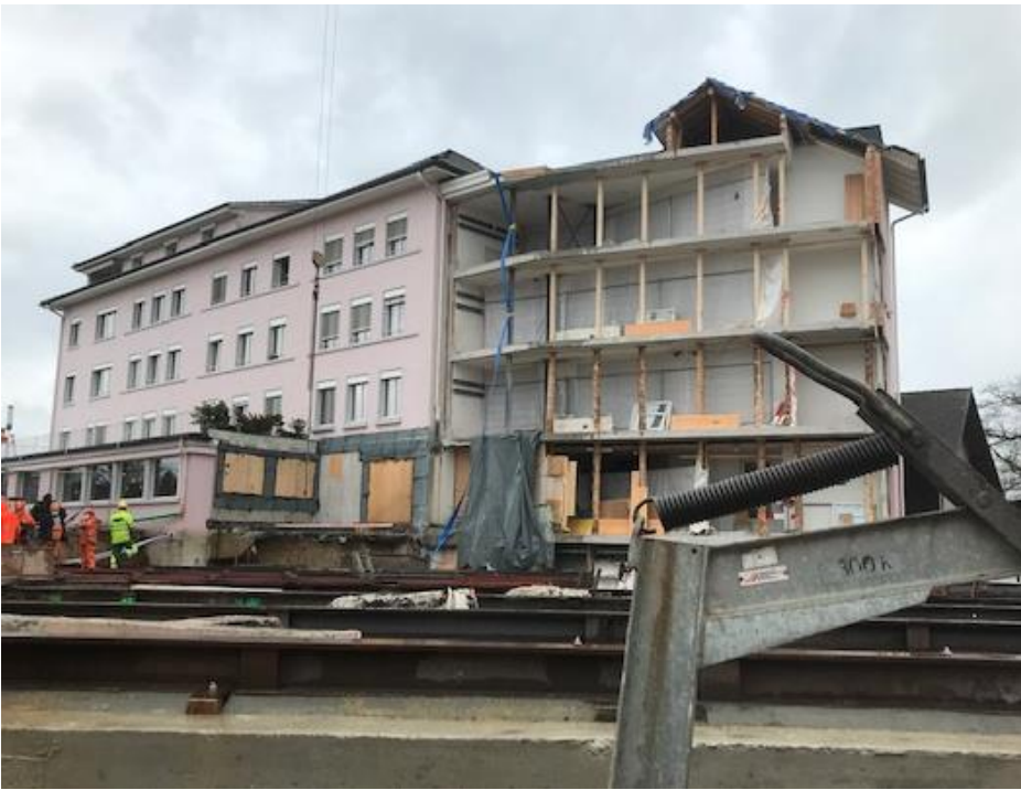
Ilustración 221, Vista al edificio posición final
