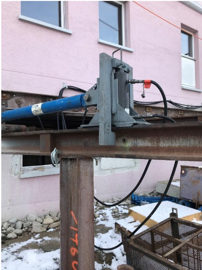
Ilustración 182, Tenazas hidráulicas cerrada bajo presión / traslado edificio Schötz Fuente: Autor
