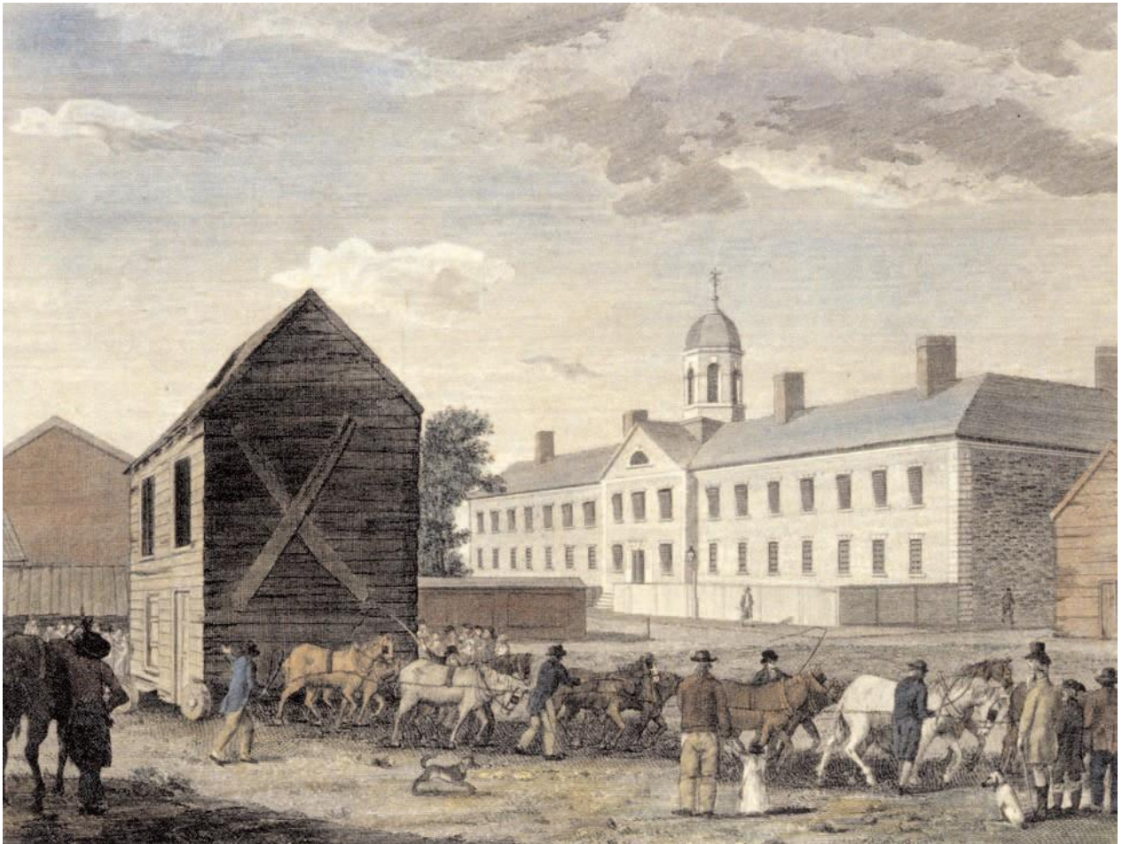
Ilustración 5, Traslado de un edificio con caballería, Filadelfia, Pennsylvania, 1794 (BIRCH 1800)
