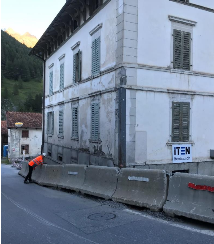
Ilustración 209, Carretera, esquina casa, Fuente: Autor
