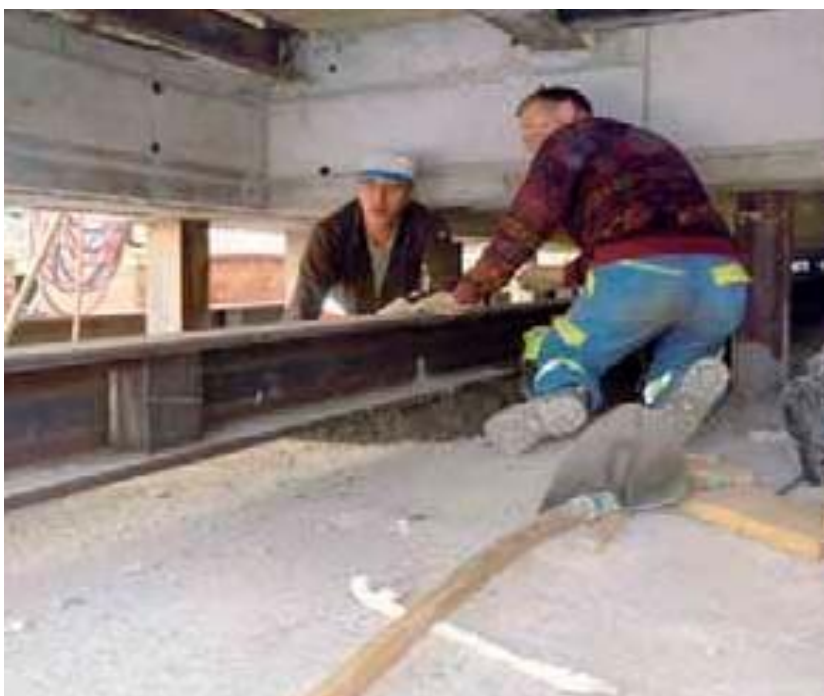
Ilustración 155, Trabajos manuales del montaje y nivelación del riel inferior fijo Fuente: ídem superior
