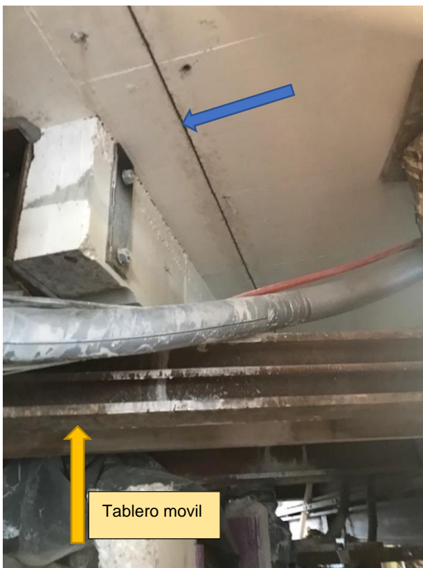
Ilustración 215, corte en forjado sótano y tablero móvil
