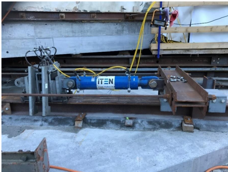
Ilustración 26, Bomba hidráulica, empuje horizontal
