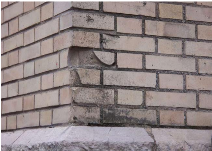
Ilustración 104, Fabrica dañada en esquina
