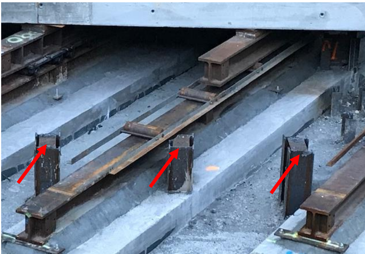
Ilustración 160, Pilares de la estructura provisional cortados Fuente: Autor Imagen (informativa, pertenece al traslado de Mulegns)
