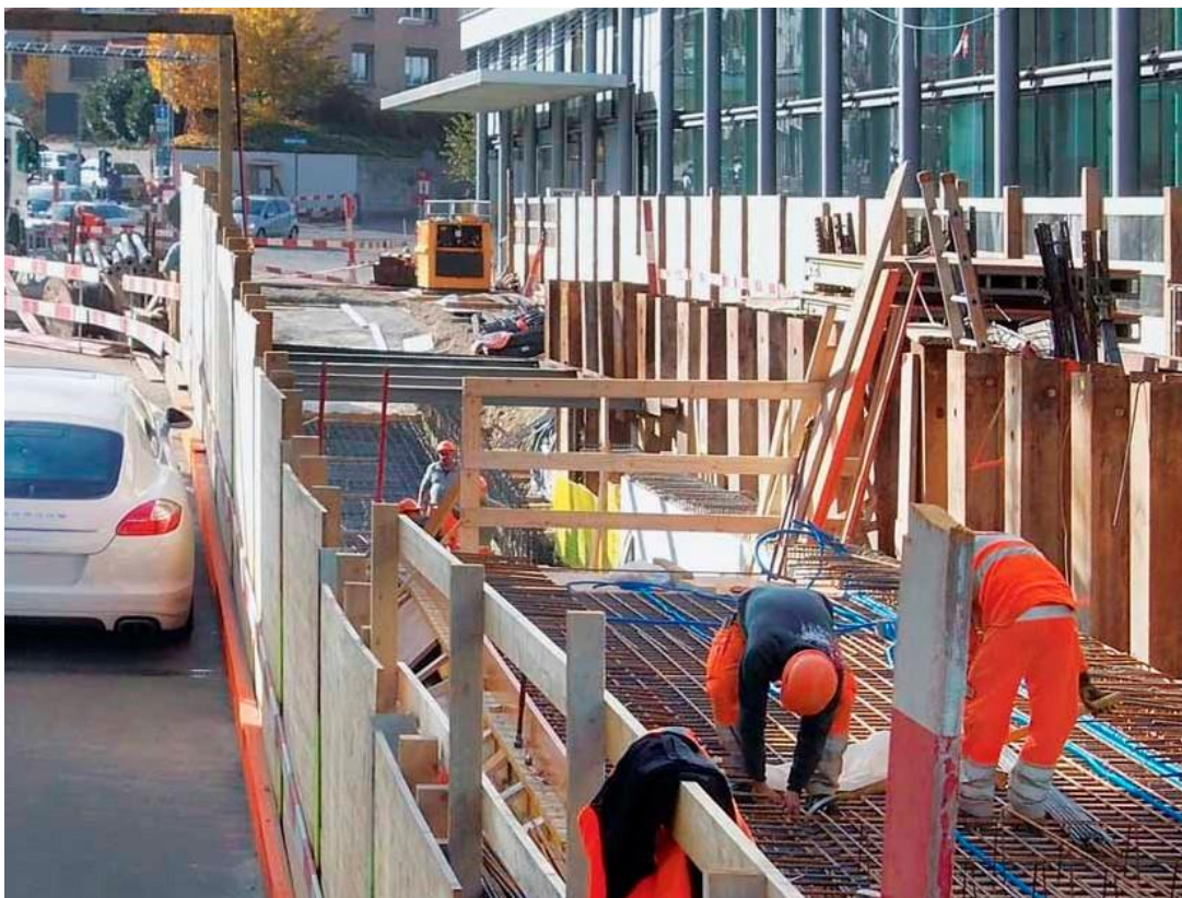
Ilustración 1212, Muro de contención y armadura de la nueva rampa
