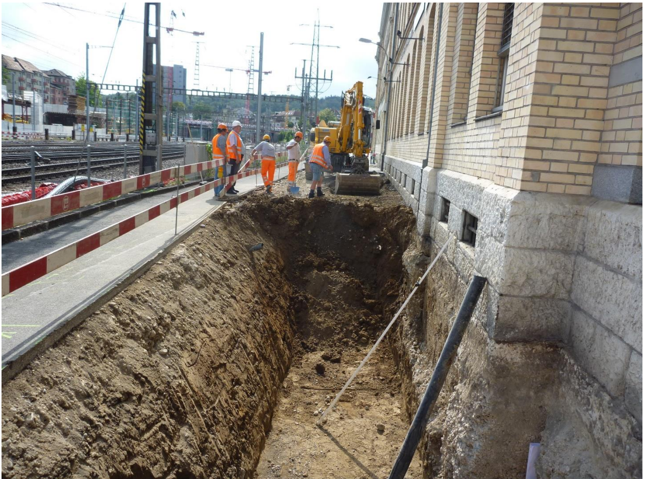
Ilustración 116, Excavación perimetral del edificio Fuente: Jäckli Geologie, Ingenieros, Zürich
