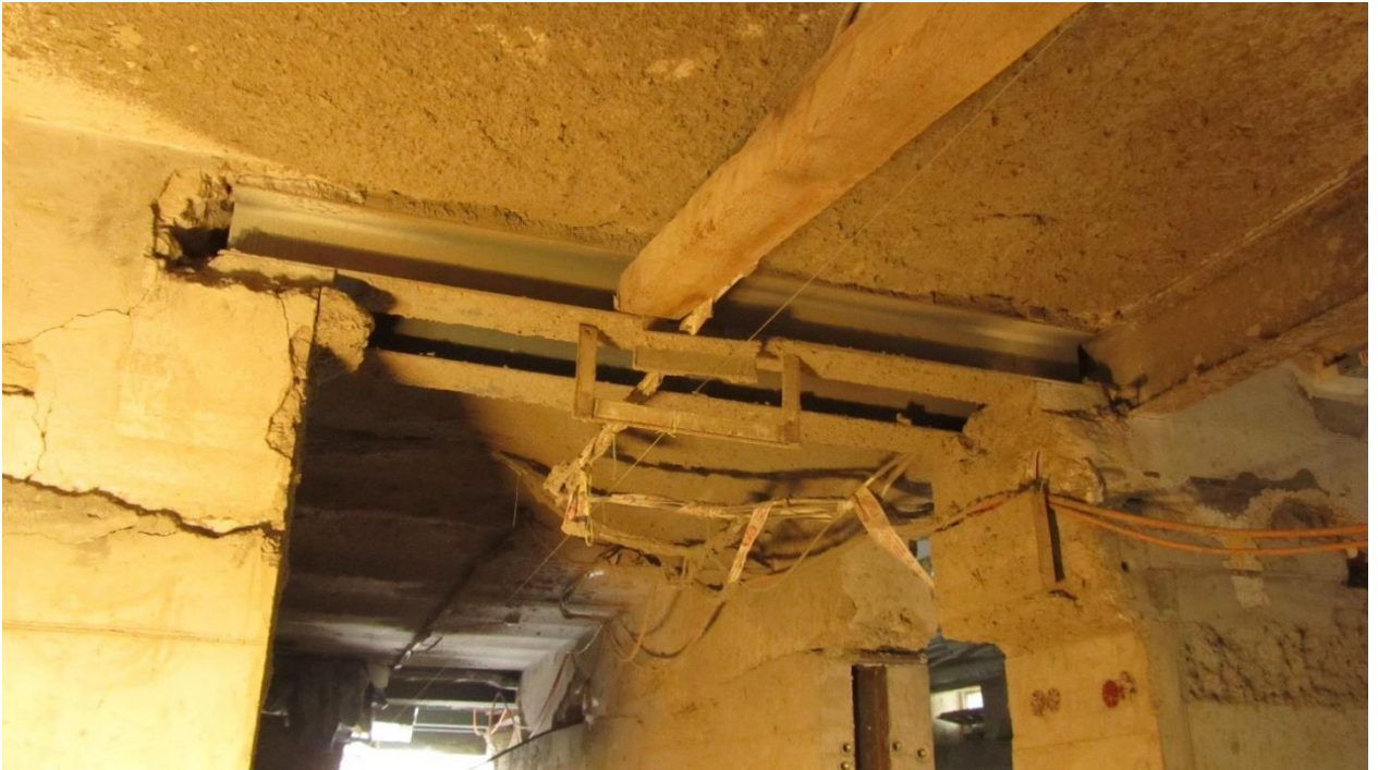
Ilustración 136, Refuerzo de dintel Fuente: Archobau, Zúrich, dirección de obra
