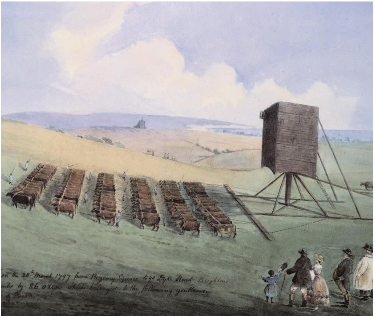
Ilustración 4, Traslado de un molino con reses, Brighton, East Sussex Inglaterra, 1796 86 reses tiran de un molino en una colina. El molino está apoyado sobre, una especie de patines.
