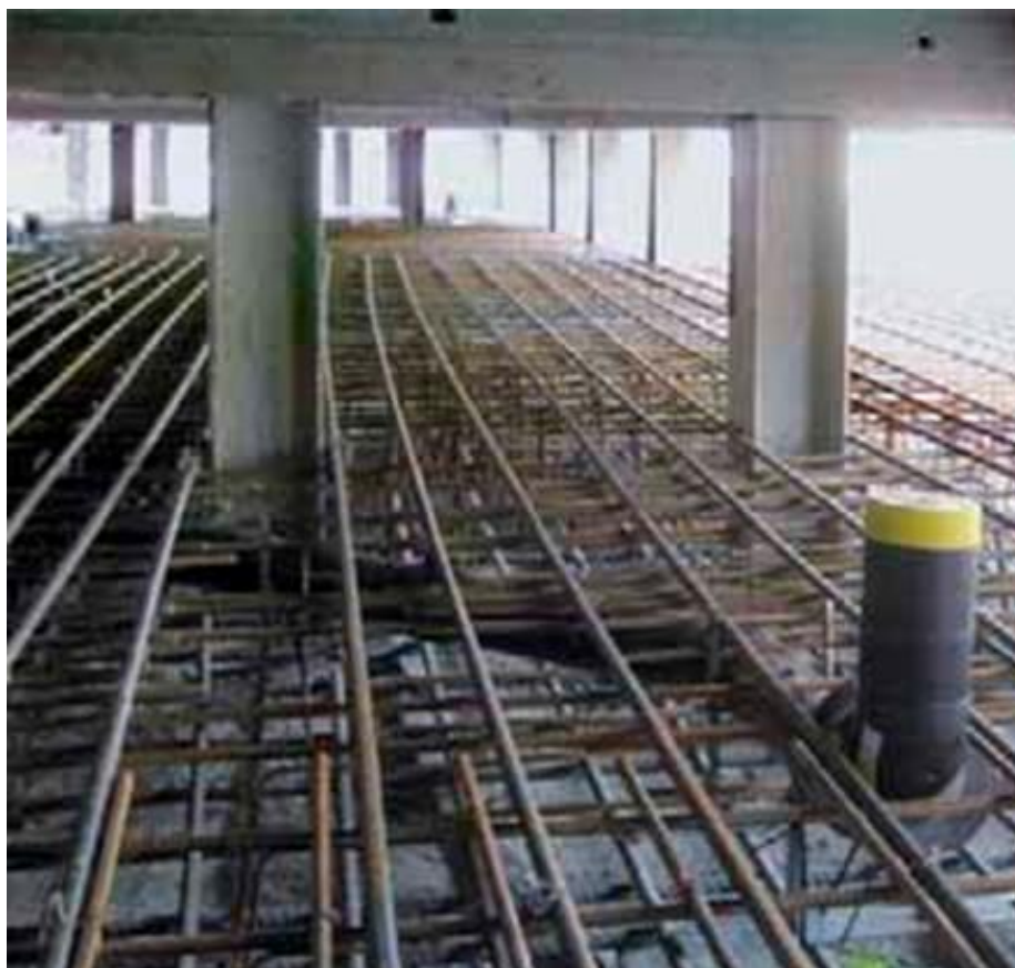
Ilustración 148, Armadura de carriles y conductos de desagües Fuente: Archobau, Zurich, dirección de obra
