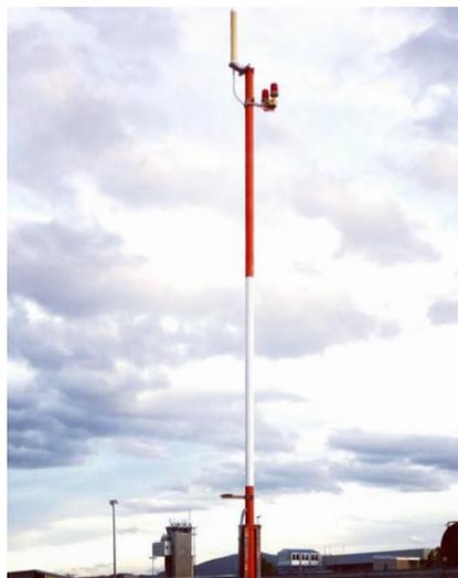
*Figura 7. Antena VDB GBAS. Aeropuerto de Málaga ((Obtenido de enaire.es)*
