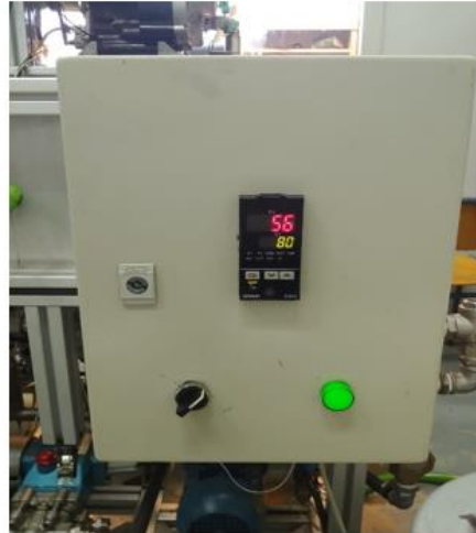
Ilustración 8. Sistema de control de temperatura lubricante.
