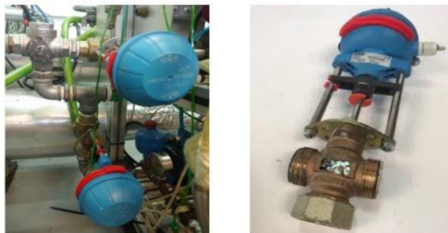
Ilustración 10. Válvula proporcional del sistema de refrigeración.
