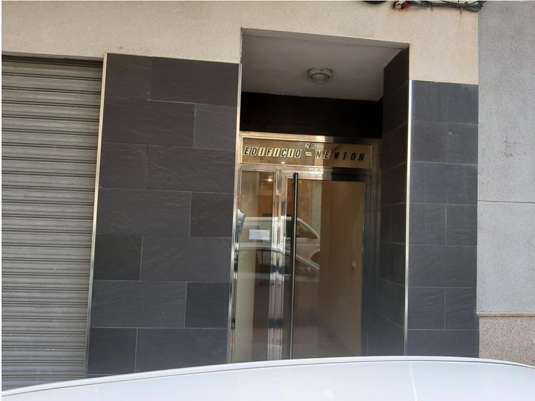
Ilustración 1. Puerta principal de acceso
