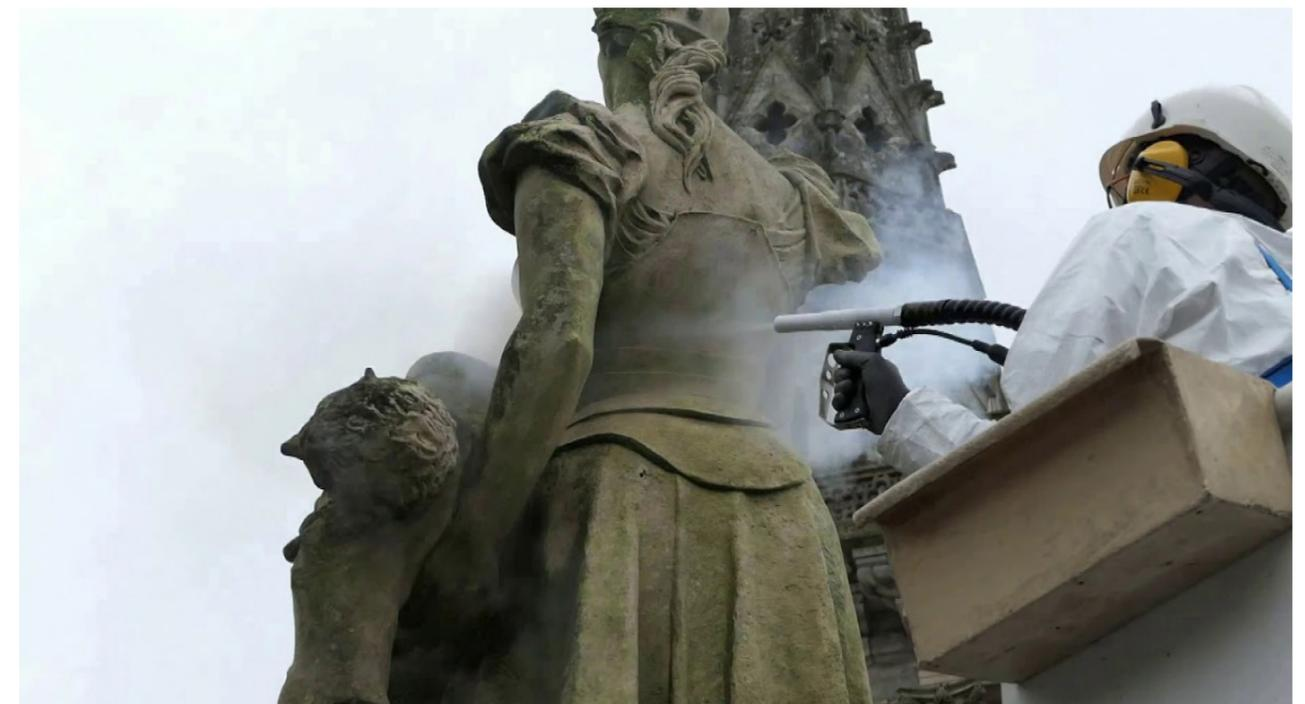
Fig. 30 Aplicación de la limpieza criogénica por un operador. Fuente: ICEsonic, 2021.
