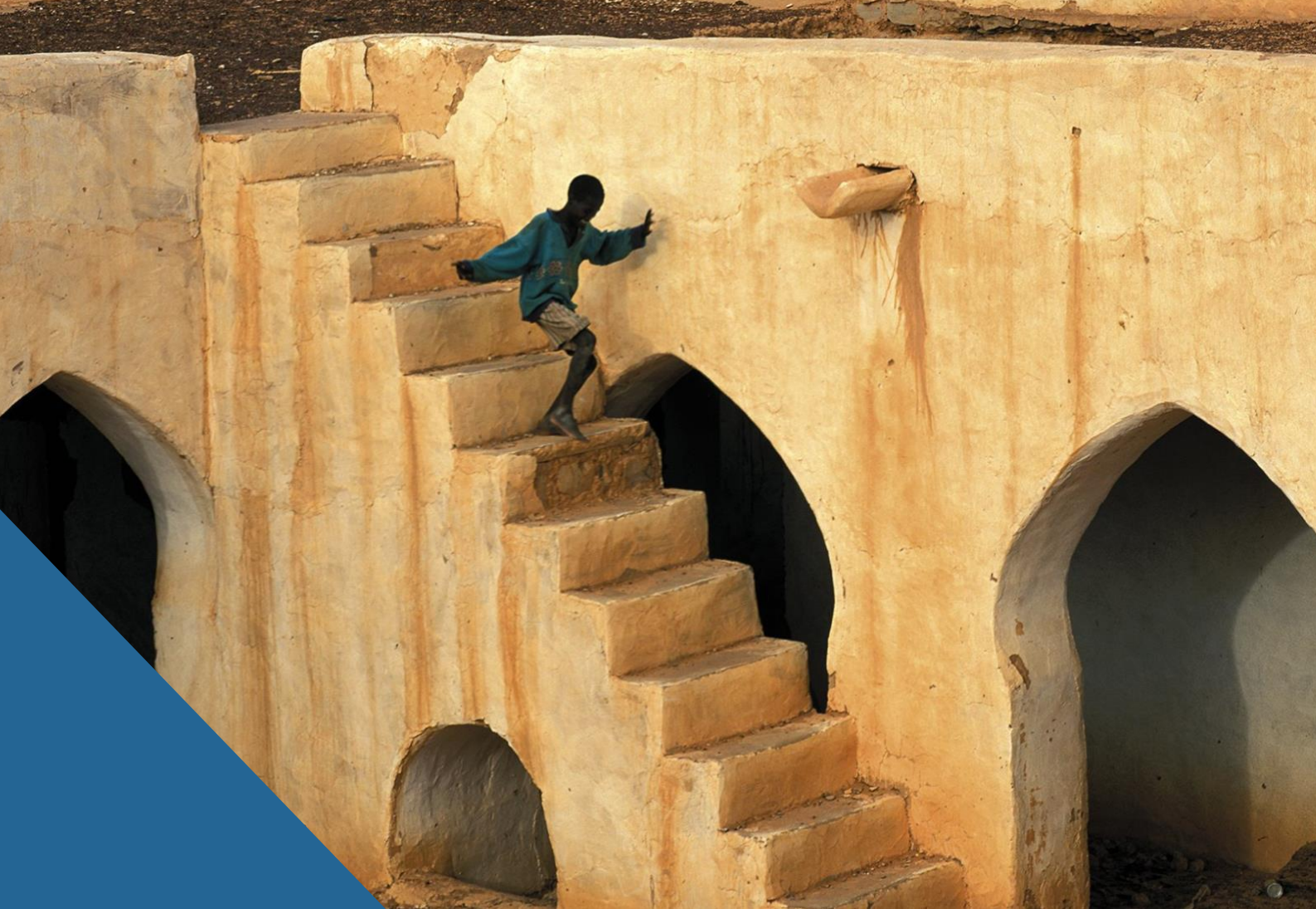
Ilustración 8: Chinguetti, Mauritania. Consecuencias del avance de la arena del desierto y la erosión. Fuente: Bruno Perousse
