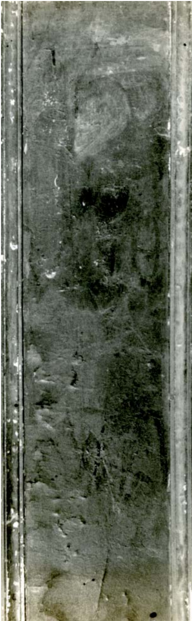
Figura 51.- Estado de conservación antes de la restauración.
