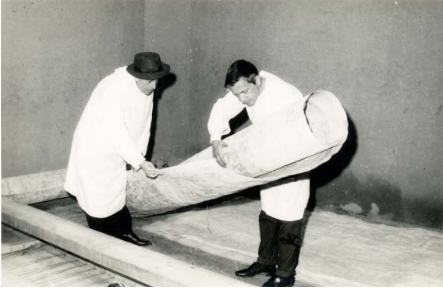
Figura 24.- Roig d'Alós y Víctor Manuel Gimeno Baquero colocando el mural arrancado para proceder a su restauración.
