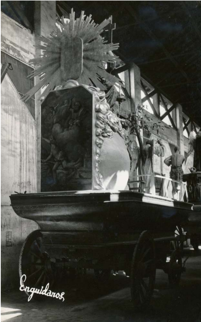
Figura 143.- Vista de la roca por la parte trasera después de la restauración.
