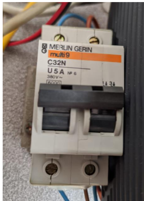
Figura 64. Interruptor magnetotérmico
