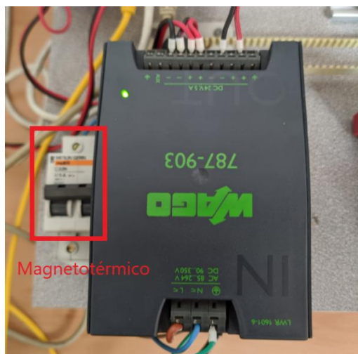
Figura 67. Conexión del magnetotérmico
