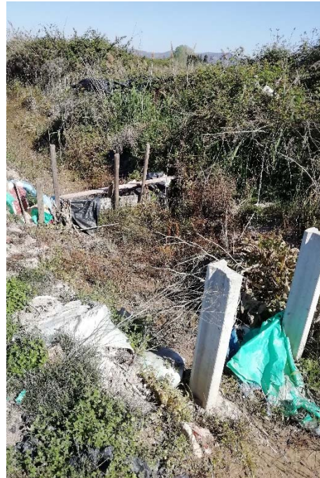
Figura 15: Estructures presents al sí d'una sèquia, probablement per a regular-ne el cabal.
