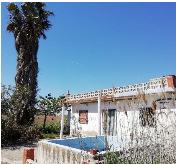
Figura 17: Casa abandonada a la zona central-nord de la Marjal.
