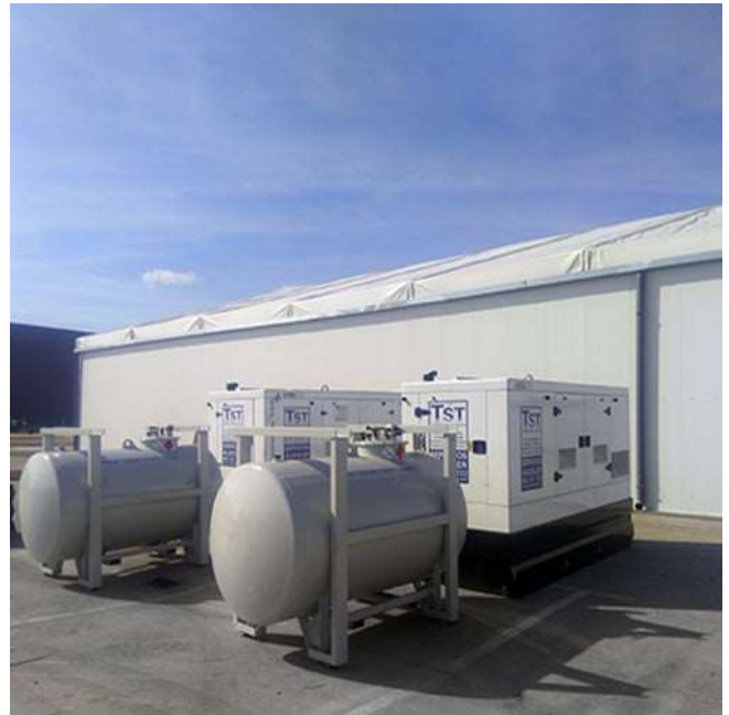
Ilustración 9. Grupo electrógeno.
