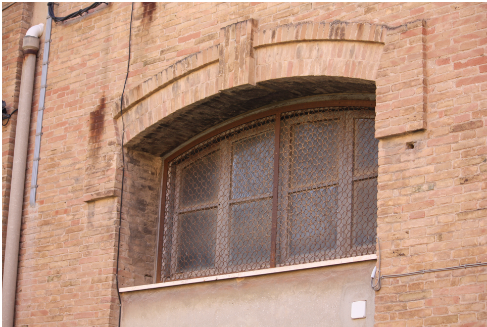
Figura 1.9: Detalle de fachada con ladrillo caravista (pre-reforma)
