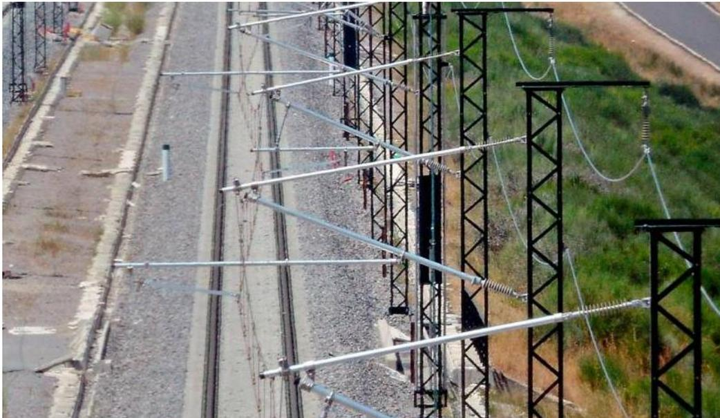
*Figura 2: Ejemplo de catenaria en zigzag.*
