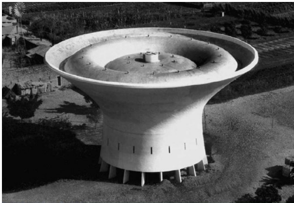
Imagen 3.2.5. Depósito de Fedala. Vista exterior.
