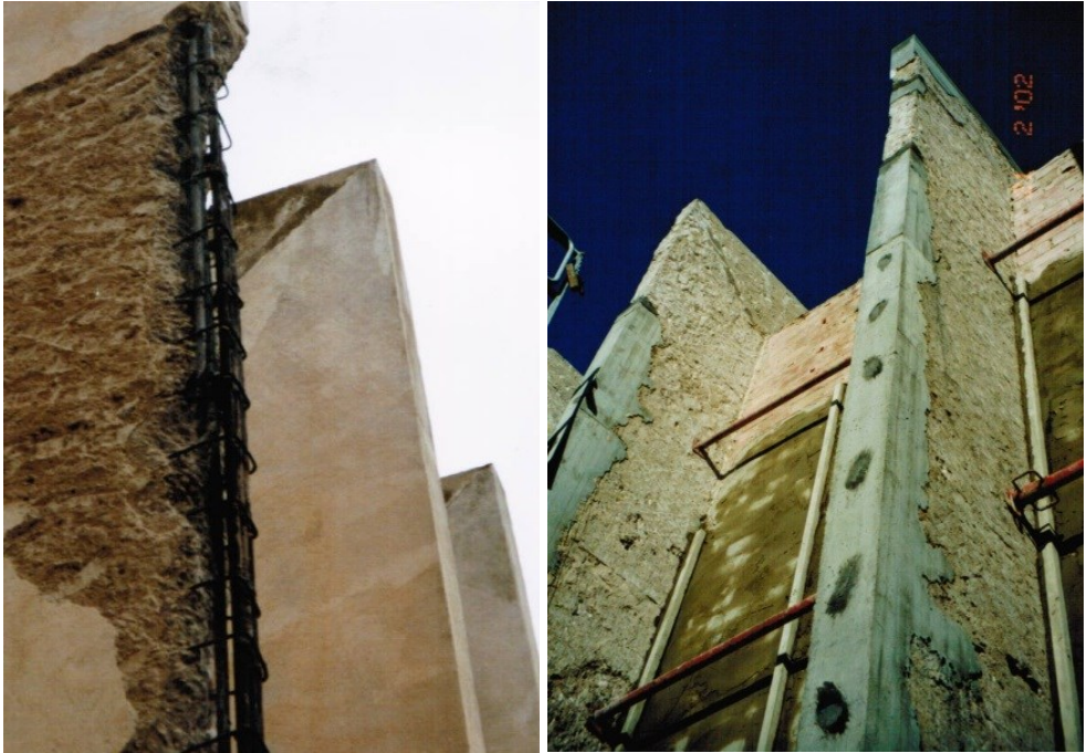
Imagen 4.1. Intervención en los pórticos-costillas de la fachada sur: Saneado (Izq.), Reposición del hormigón (Der.).
