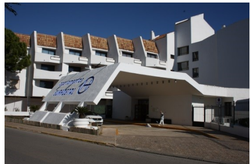
Imagen 2.6. Marquesina de acceso.
