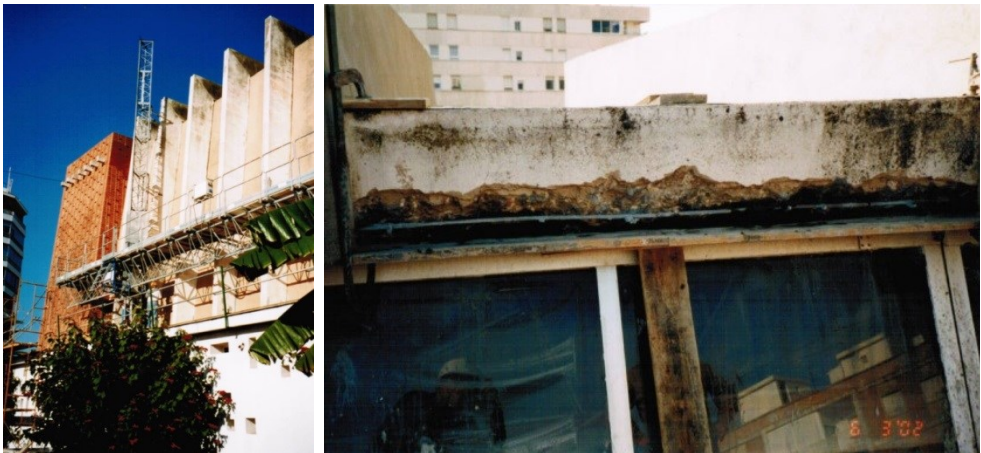
Imagen 1.1 Estado que presentaba los elementos estructurales de la fachada sur: Pórticos-costillas (Izq.); detalles de la pérdida de recubrimiento de la losa. (Der.)
