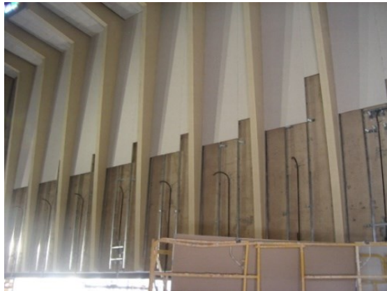
Imagen 4.2 Trasdosado de placas de yeso en el interior de la fachada norte
