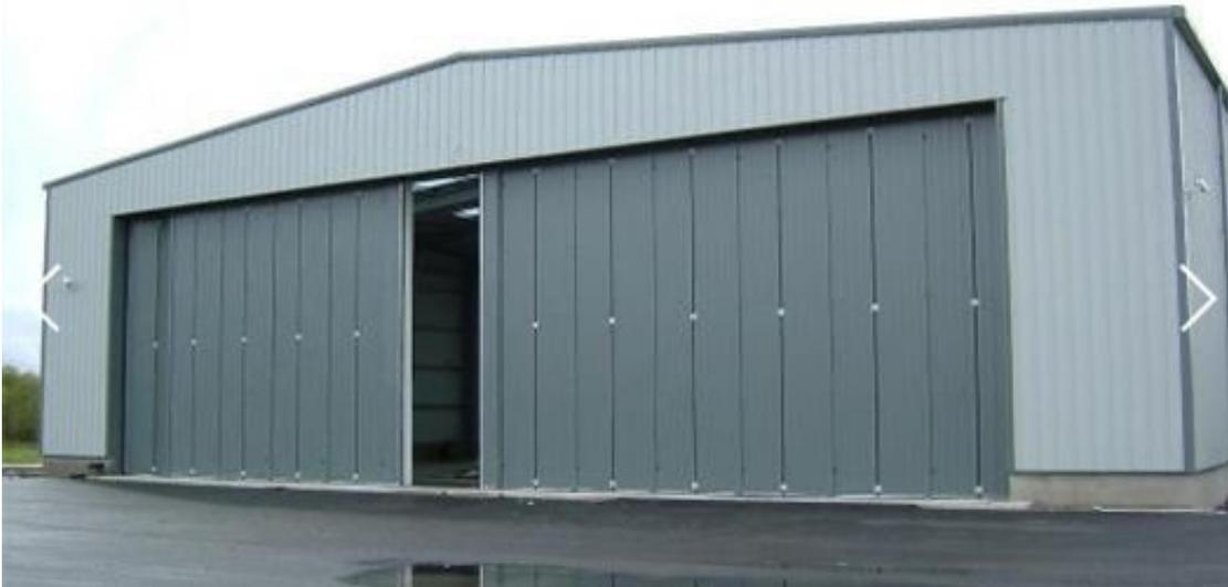
Figura 43: Ejemplo de una puerta de hangar plegable tipo acordeón. (36)
