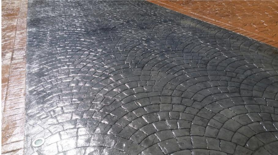
*Ilustración 1: Pavimento hormigón impreso*
