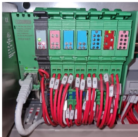
Ilustración 20. Periferia distribuida de Phoenix Contact (Fuente: Elaboración propia)
