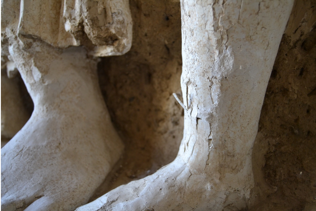
Fig. 104: Ejemplo de fisuras, craquelado y pérdida de estuco a la altura de los tobillos de las esculturas de la Capilla 3
