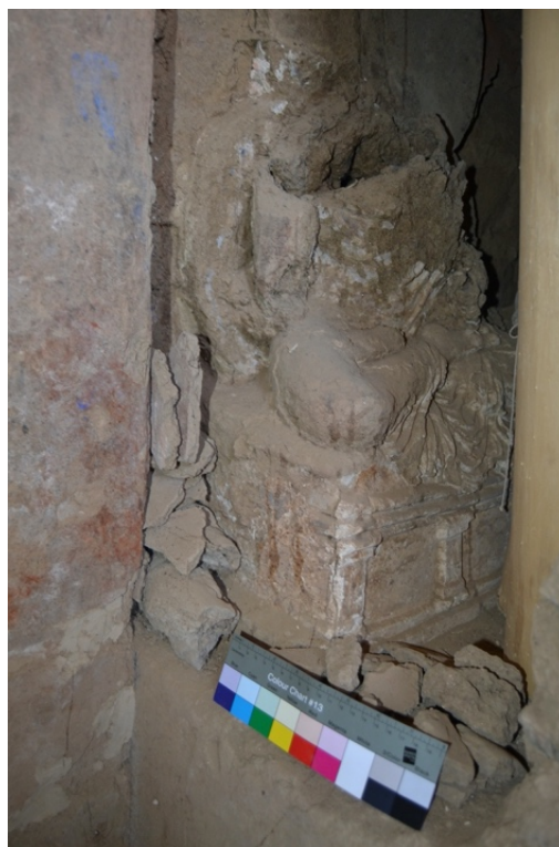
Fig. 124: Detalle del Buda sentado con las piernas cruzadas localizado en el pequeño nicho de la Capilla 15. A la altura de los hombros, el negativo de una estructura interna, hoy desaparecida. Presencia de chorretones superficiales de resina acrílica evidenciando consolidaciones realizadas durante las excavaciones.
