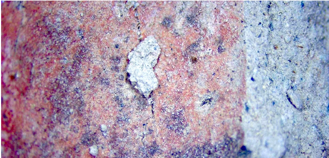
Fig. 116: TN4. Detalle del acabado rojo directamente sobre capa de arcilla. Lupa 8x.
