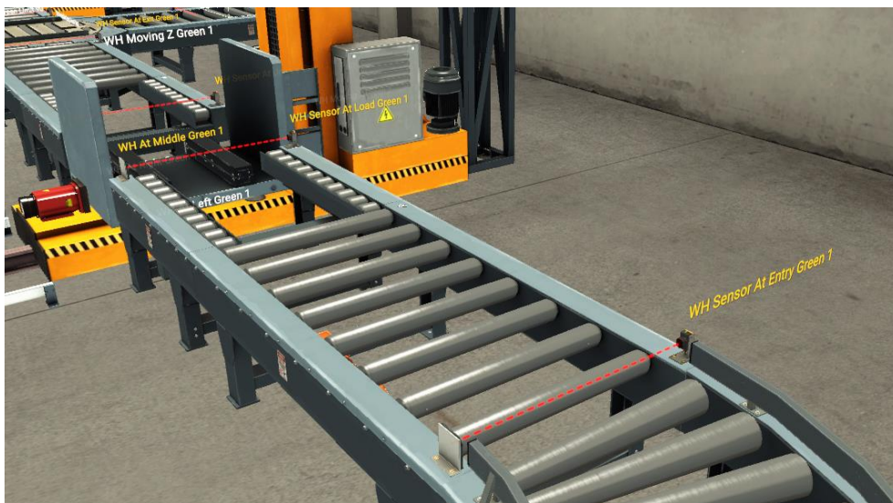
Figura Anexo 13. Sensores Zona 6 (6) de Factory I/O.
