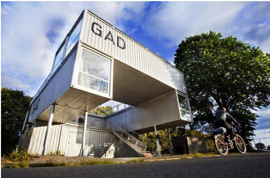
**Imagen 42. Perspectiva para visualizar pilares que soportan contenedores en voladizo**
