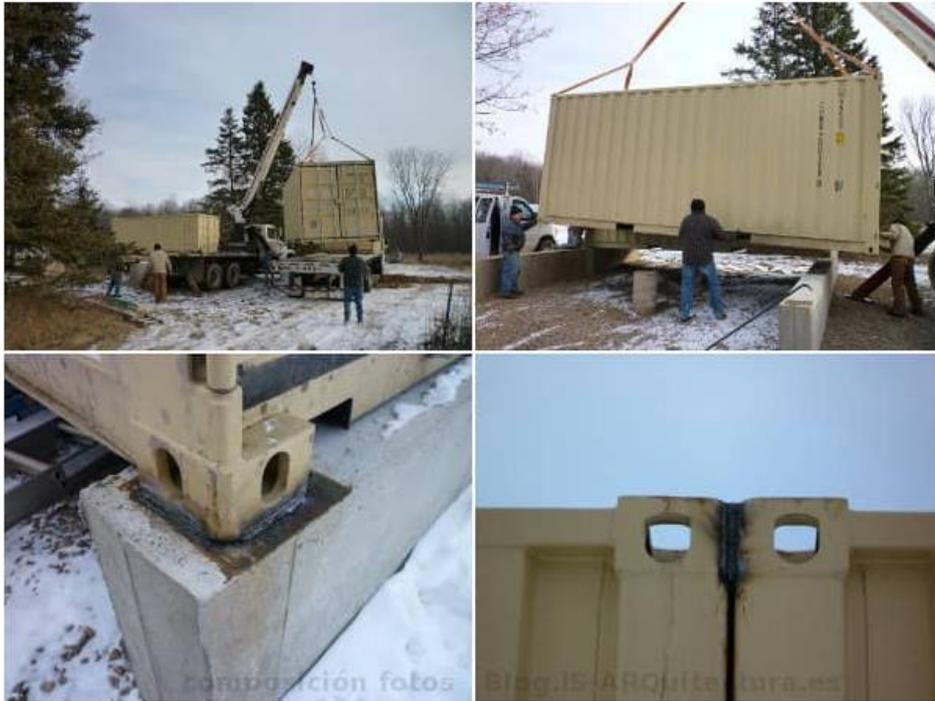
Imagen 31. Placas de anclaje en estructura para contenedor
