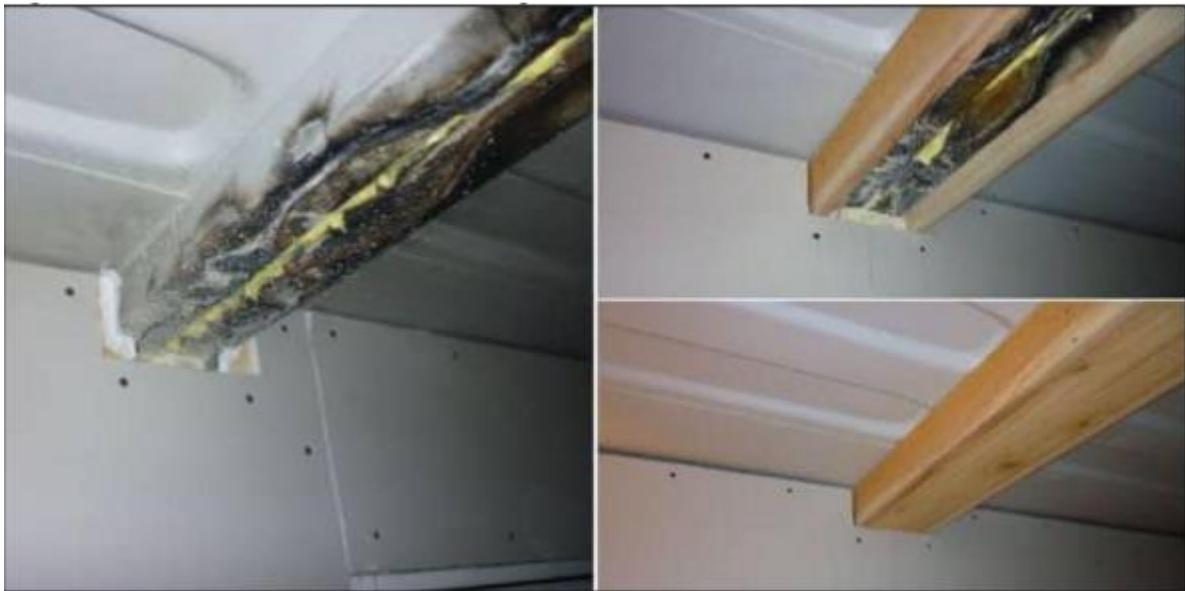
**Imagen 33. Refuerzo de vigas de acero**
