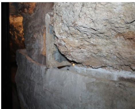
[53] Canal de reparto construido en muro y revestido con mortero. Bodega Fernando M. Calle del Almazar. 2021 Fuente: Nerea Almonacid Cambres
