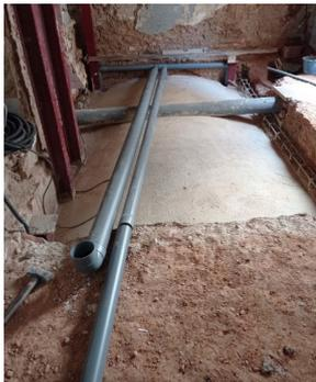
[116] Salida de nuevo respiradero con tuberías de PVC desde trullo cubierto.
