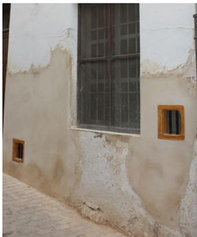
[117] Salida de nuevos respiraderos a diferentes alturas, con tuberías de PVC, vista exterior.
