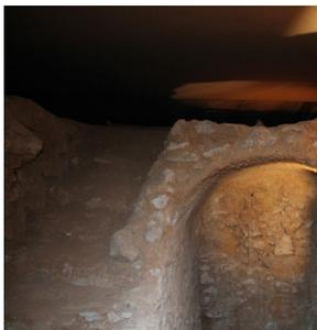
[109] Acceso original eliminado para realizar forjado de la planta superior.
