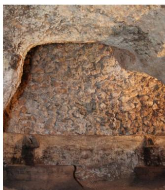
[102] Separación con muro de piedra tosca de dos bodegas.
