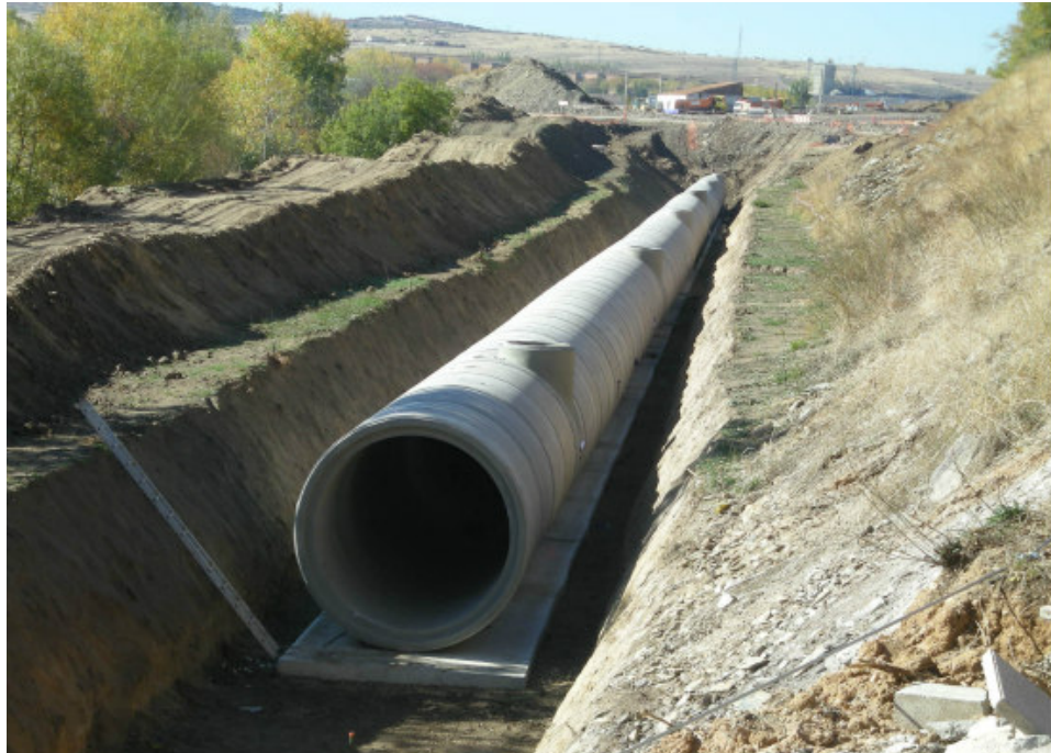
Ilustración 79. Obra de canalización pública por empresa ANDECE, Madrid. Fuente: Revista "Obras Urbanas", 2017.
